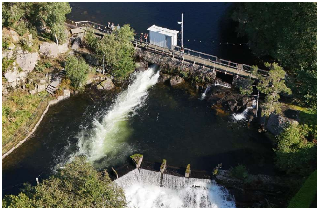
Figur 1 Selura dam sett fra nedstrøms side.
