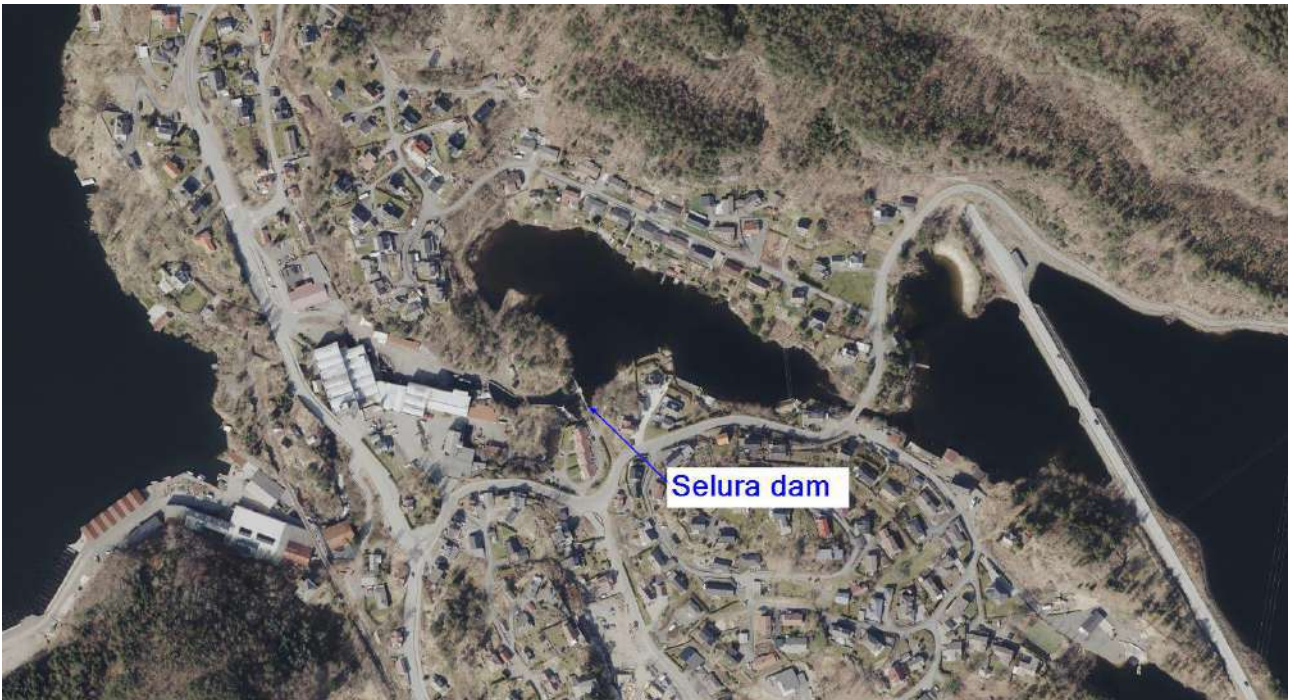
Figur 1-2: Oversikt over vassdragsanlegget.
