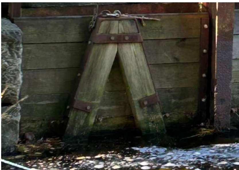
Figur 3-5: Oppstrøms side av bjelkestengsel i søndre flomløp
