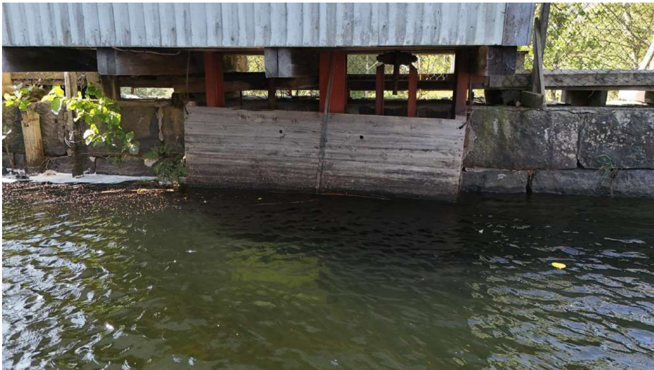
Figur 3-6: Bilde av bjelkestengsel på oppstrøms side av dammen over «midtre» flomløp
