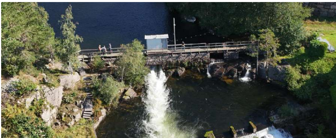
Figur 2 Selura dam sett fra nedstrøms side.
