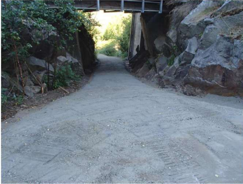
Figur 7: Tildekket tiltaksområde sett fra fabrikk (COWI, 2014)
