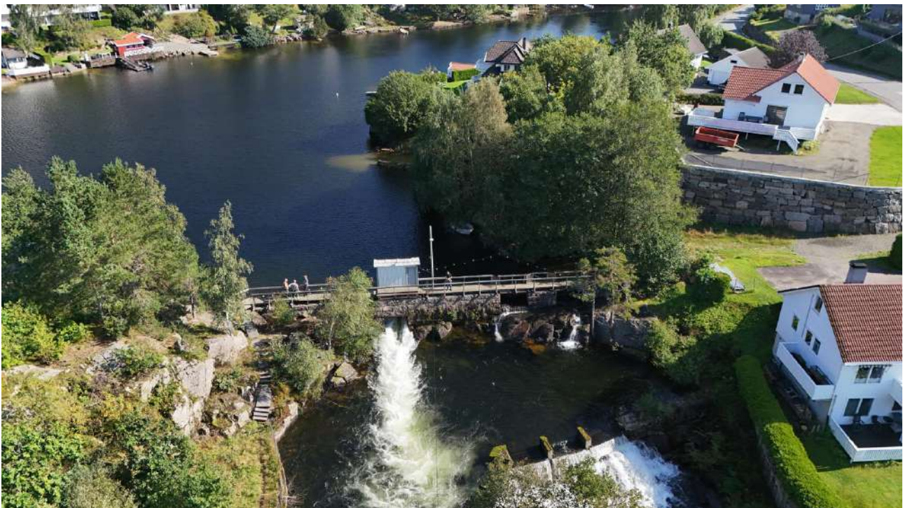
Figur 1-3: Dronebilde sett fra nedstrøms side
