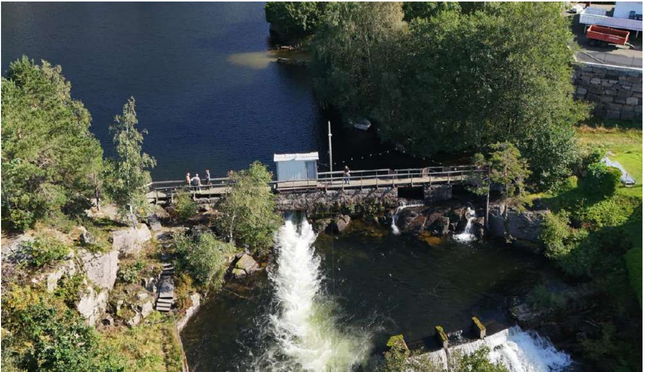
Figur 7 Selura dam sett fra nedstrøms side.
