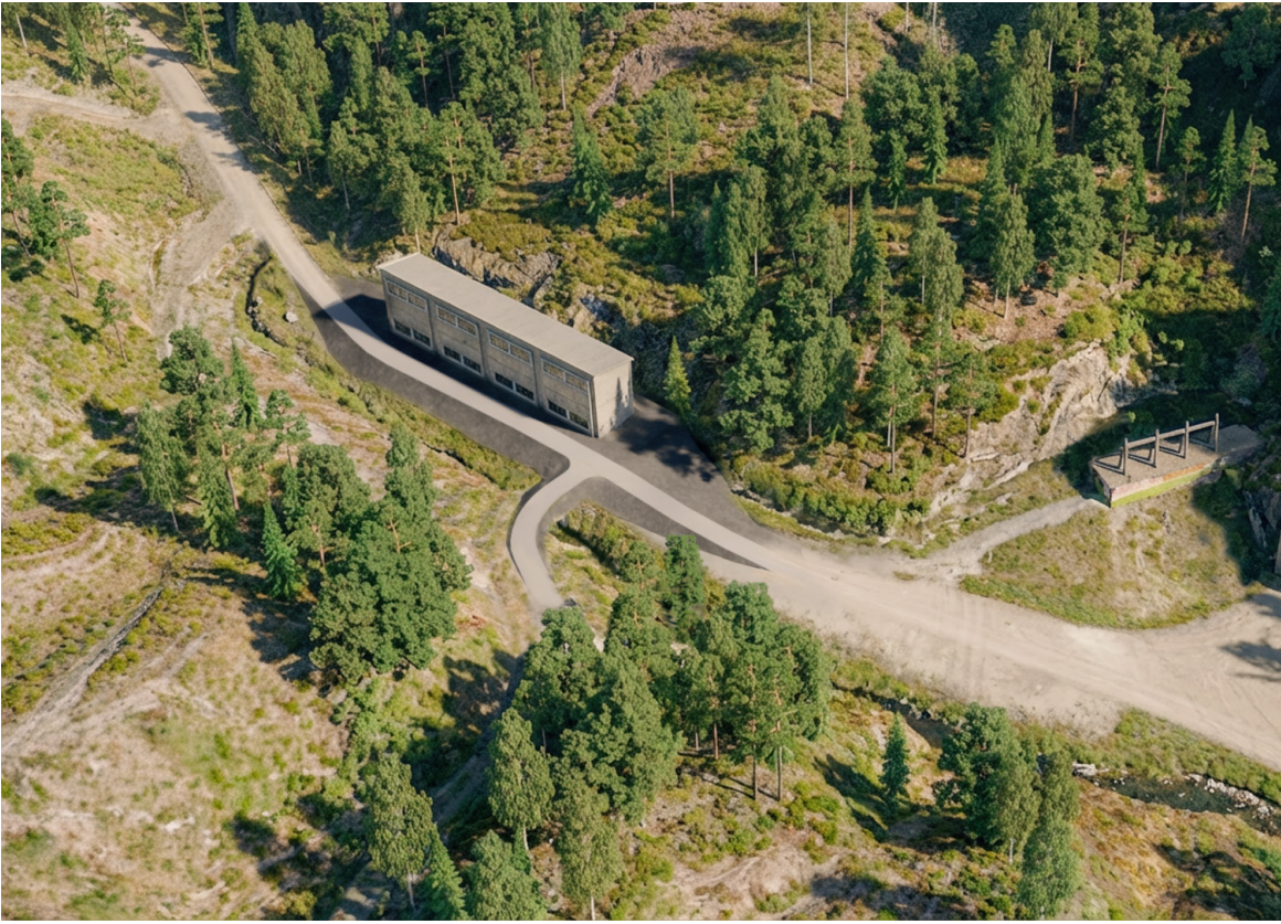
Figur 2 Nærbilde av omsøkt transformatorbygg.
