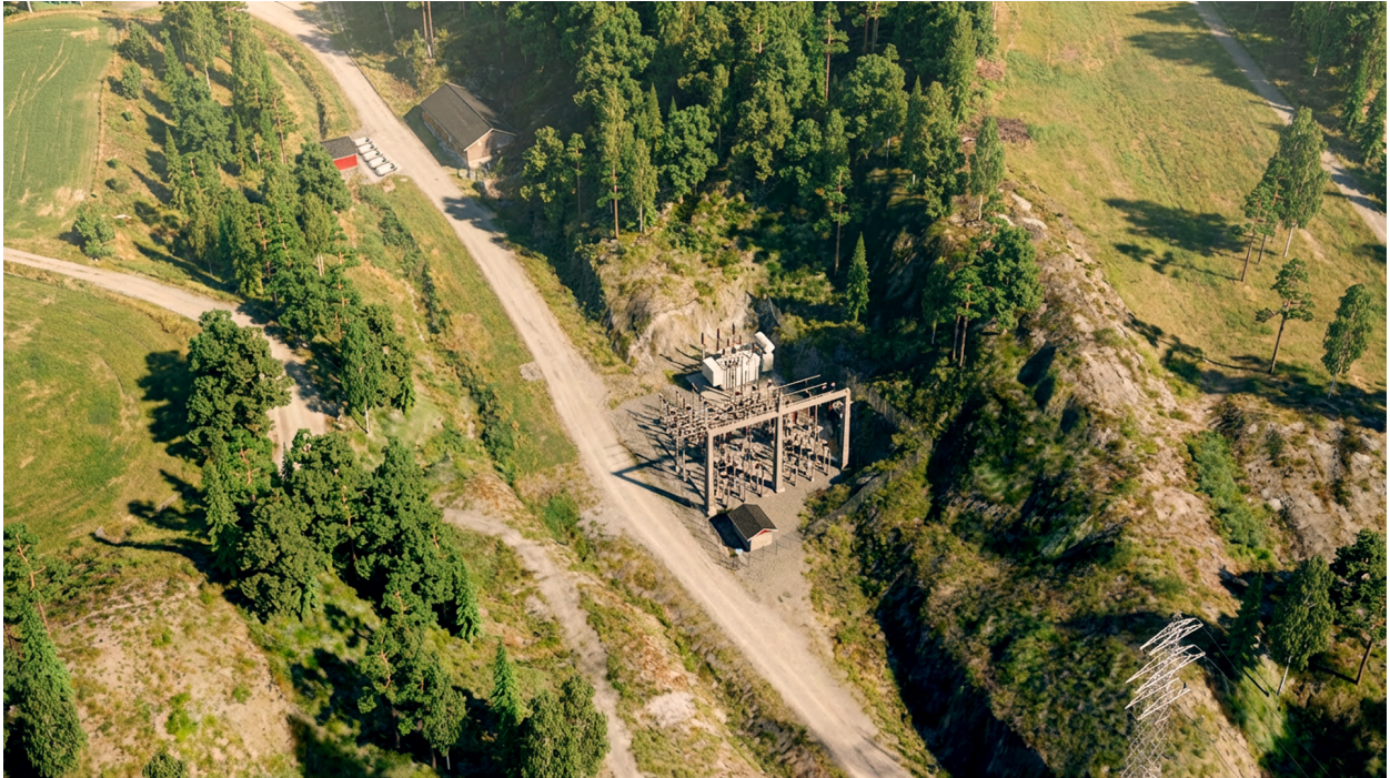
Figur 4 Kaggefoss transformatorstasjon. Omsøkte tiltak er beskrevet i søknaden.
