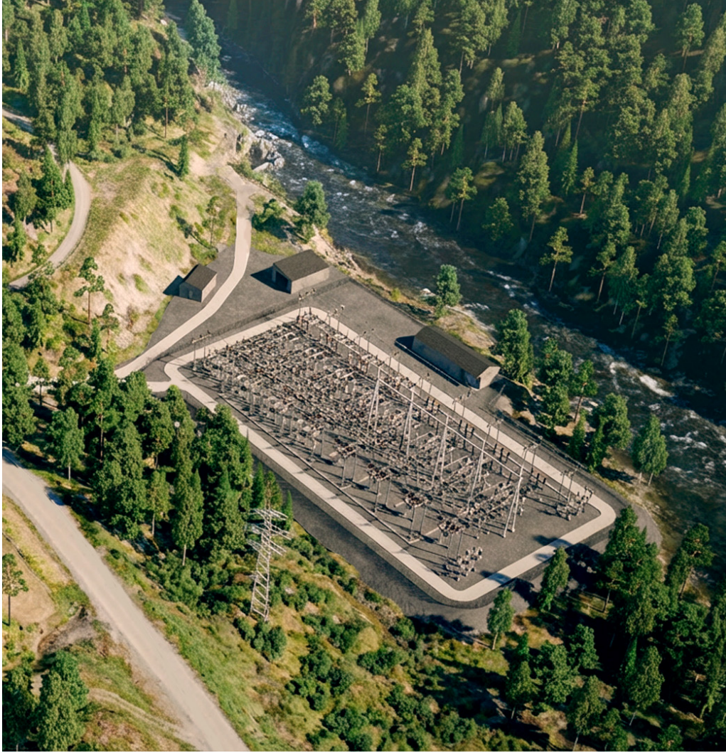
Figur 3 Omsøkt 132 kV koblingsanlegg.
