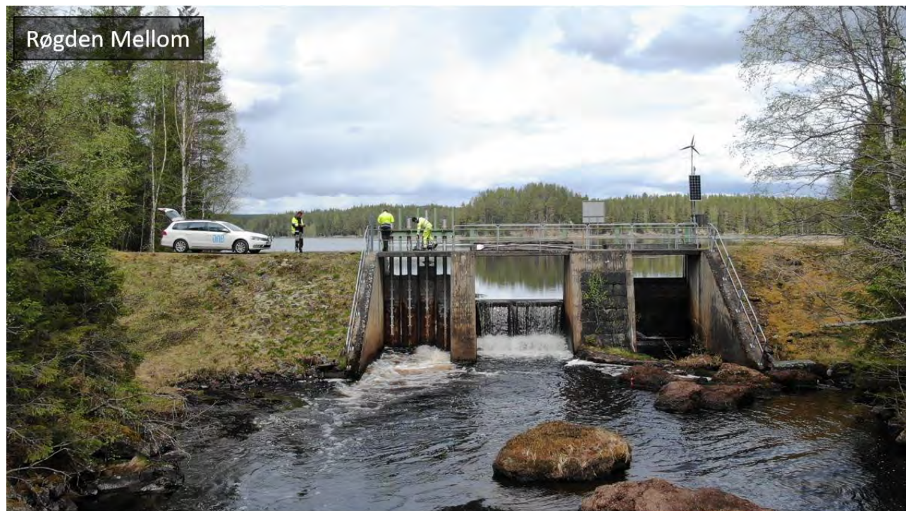
Figur 3 Røgden Mellom sett fra nedstrøms side.
