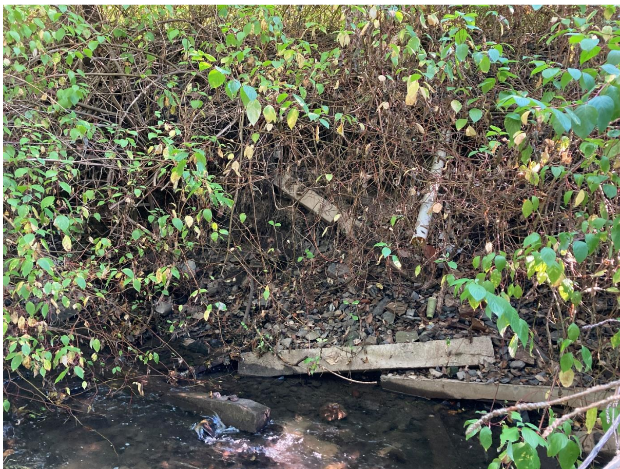
Figur 3-5: Bilde 4 av fylling mot øst.
