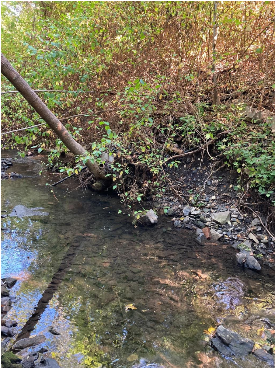
Figur 3-10: Bilde 9 av fylling mot øst.
