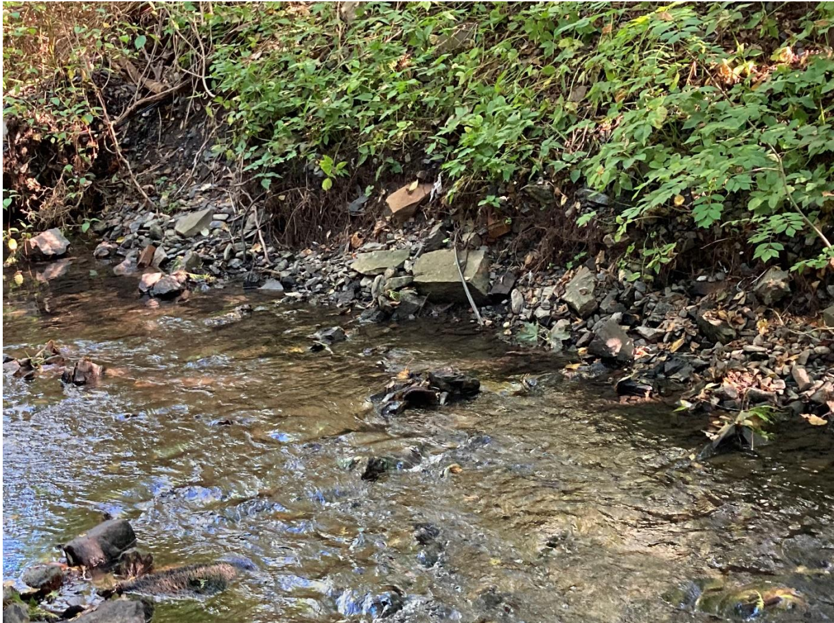
Figur 3-4: Bilde 3 av fylling mot øst.
