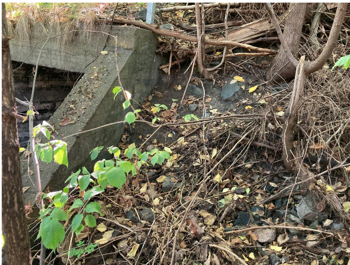
Figur 3-2: Bilde 1 av fylling rundt kulvert under fylling.
