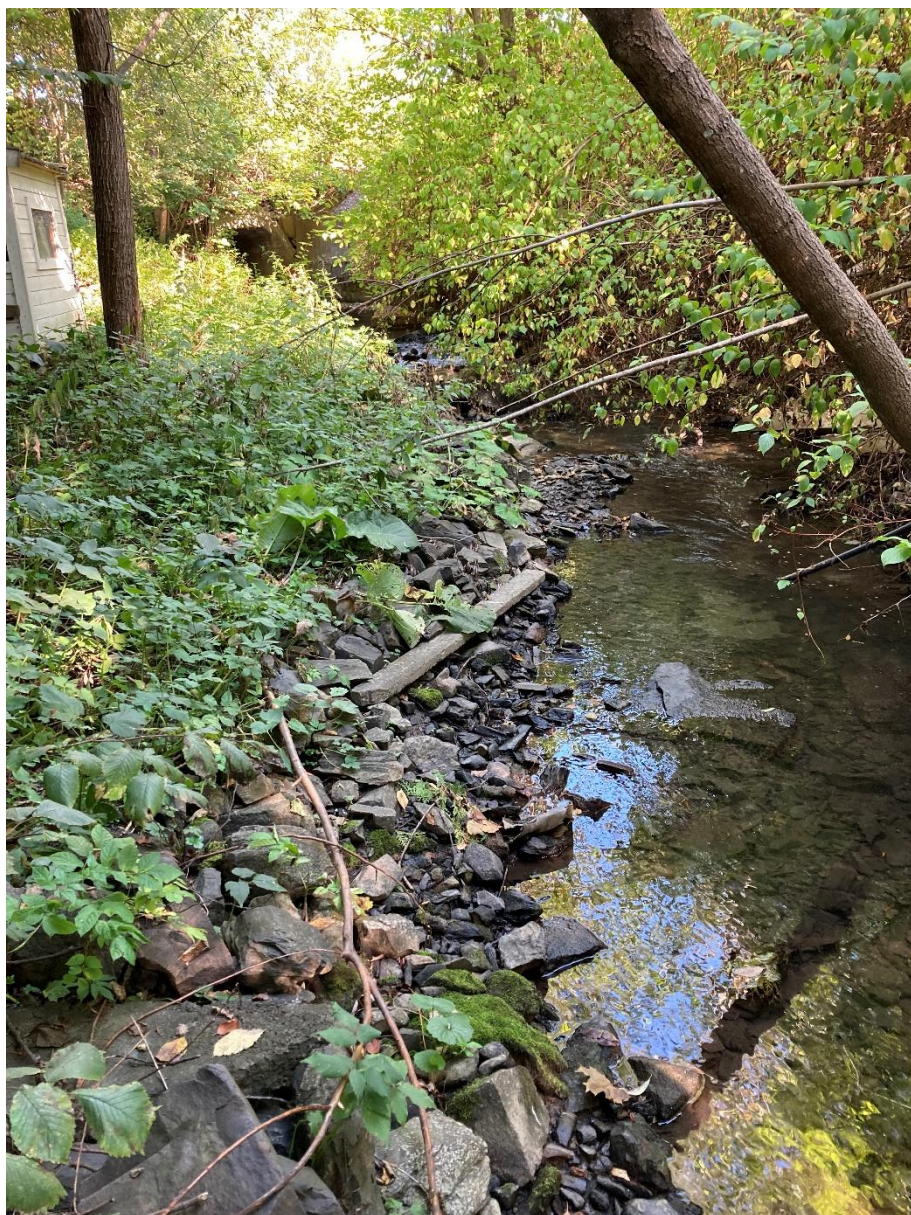
Figur 3-8: Bilde 7 av erosjonssikring mot vest. Bilde er tatt mot nord.
