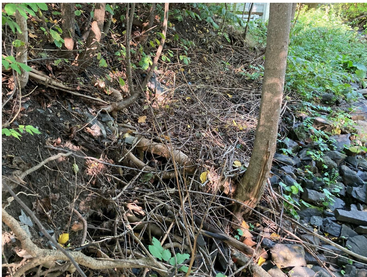
Figur 3-9: Bilde 8 av erosjon opp i skråning mot vest.
