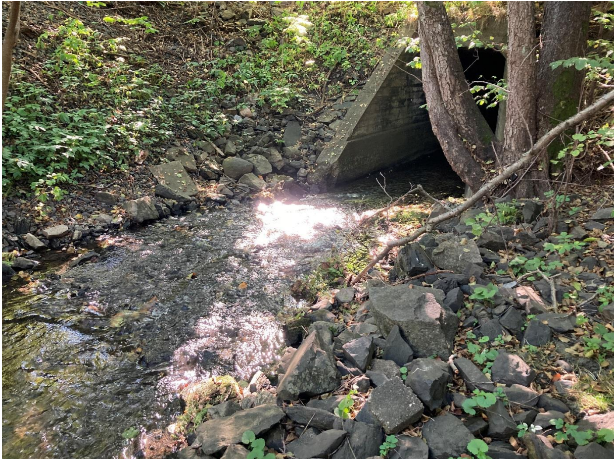
Figur 3-3: Bilde 2 av innløp mot kulvert under fylling.
