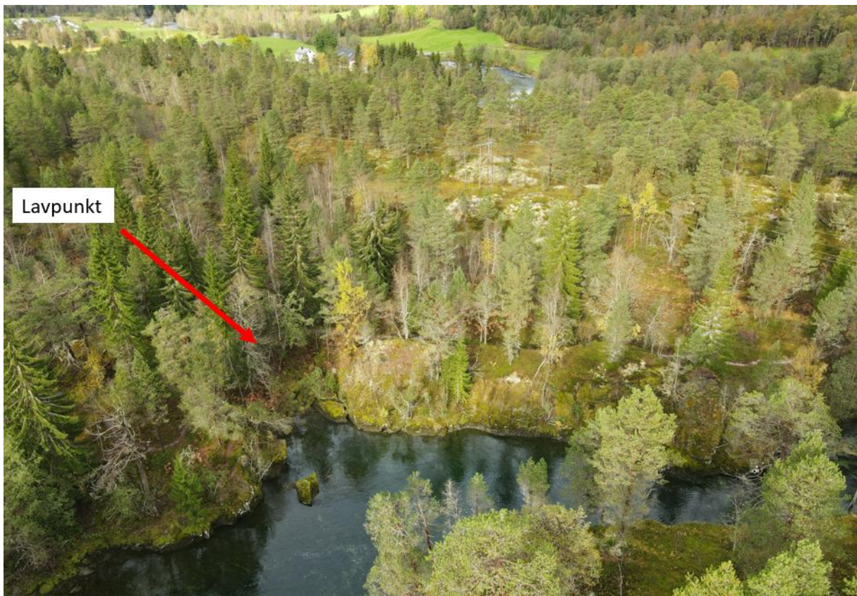
Figur 5: Bilde av knekk i juvet oppstrøms det vurderte området. Lavpunktet er indikert med rød pil. Vurderte bygg kan ses i bakgrunnen, øverst i bildet.
