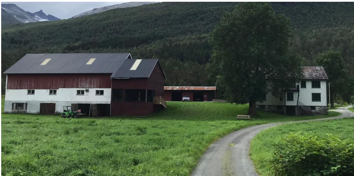
Figur 1: Låven det ønskes bruksendring for. Bilde tatt fra bru nord i det vurderte området.
