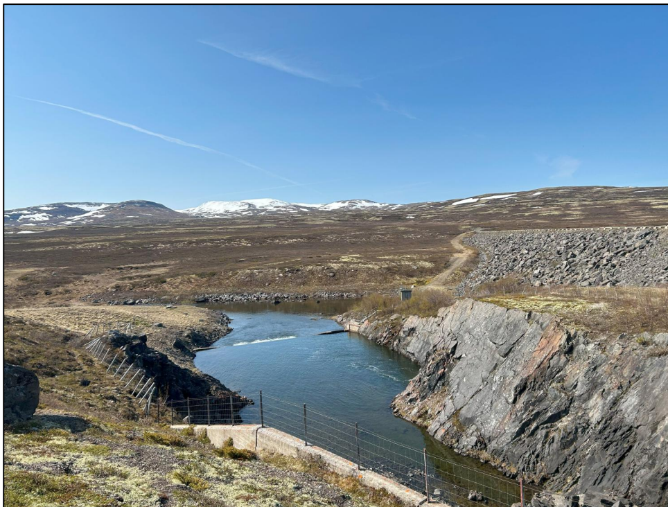
Figur 1-3: Flomløpskanalen sett fra nordre vederlager mot nedstrøms. Her er det allerede sprengt steinbrudd i grafittskifer som ligger på østsiden av dammen.
