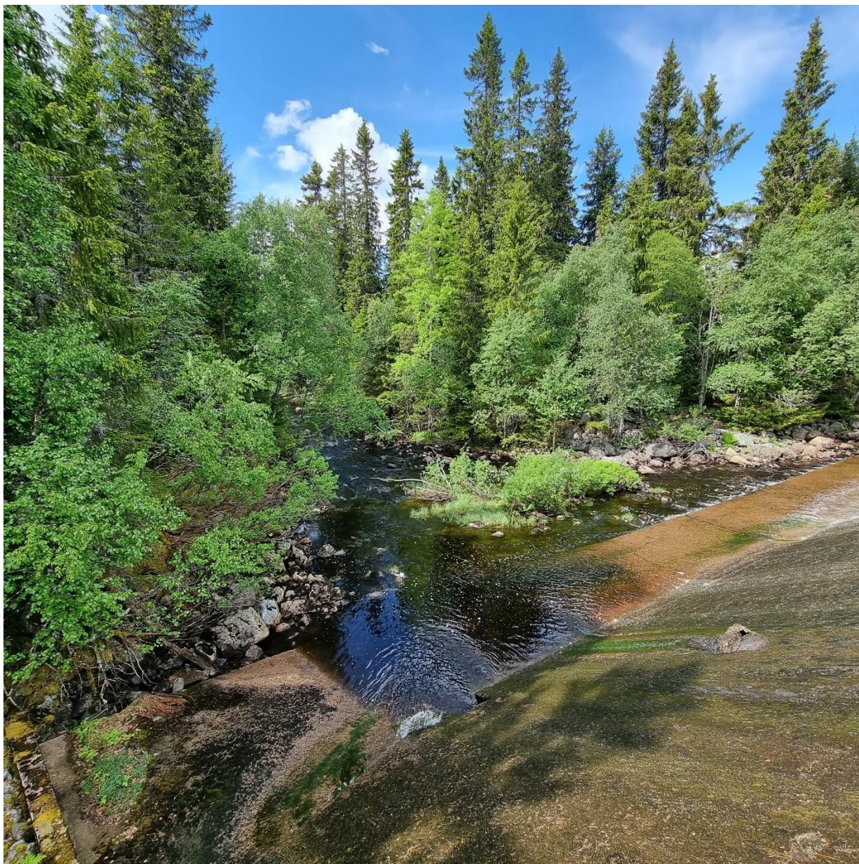
Nedstrøms side av dam. Bilde tatt 31.05.2024
