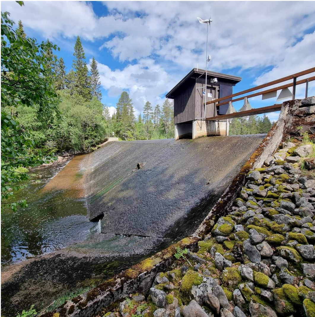
Overløp sett fra sør-østlige vederlag. Bilde tatt 31.05.2024
