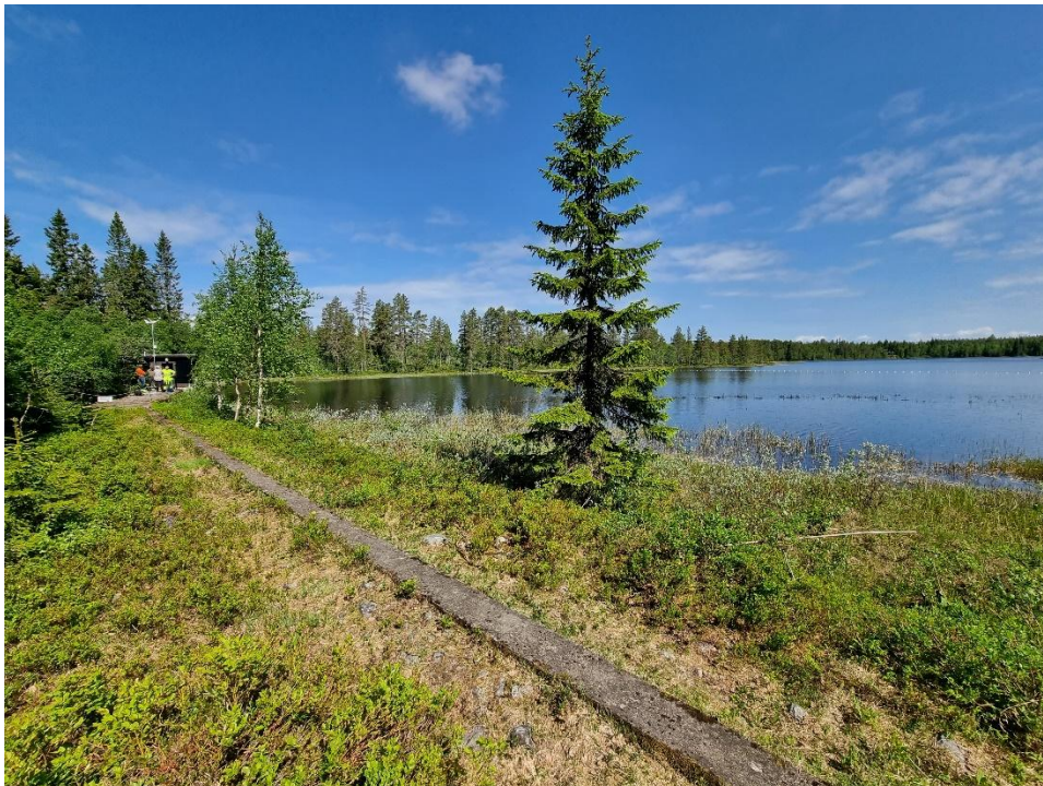
Dam sett fra sør-østlige vederlag. Bilde tatt 13.06.2023
