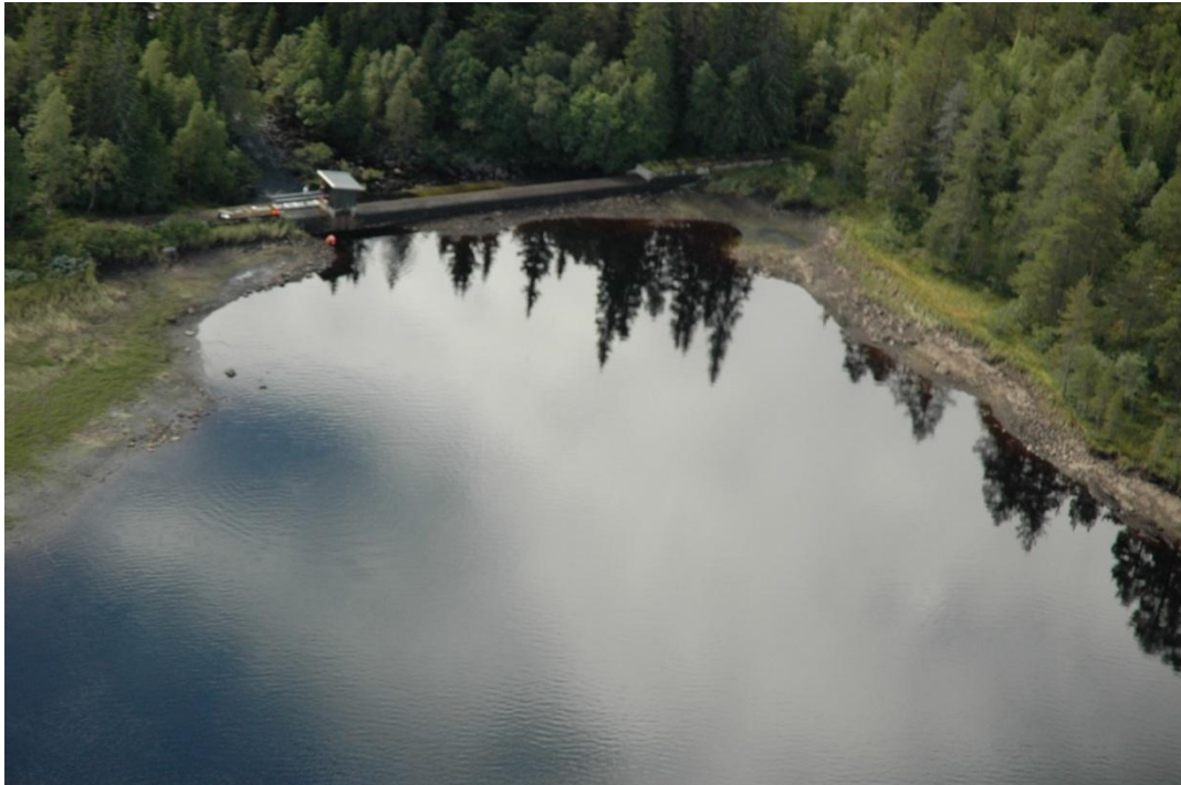
Flyfoto av nedtappet magasin. Bilde tatt i 2012.
