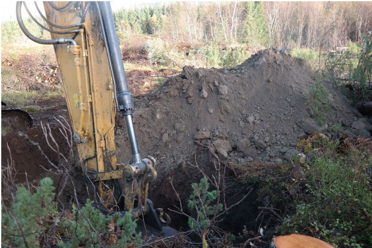
Figur 5 - Prøvegrop DEP2, gravedybde ca. 2,0 meter
