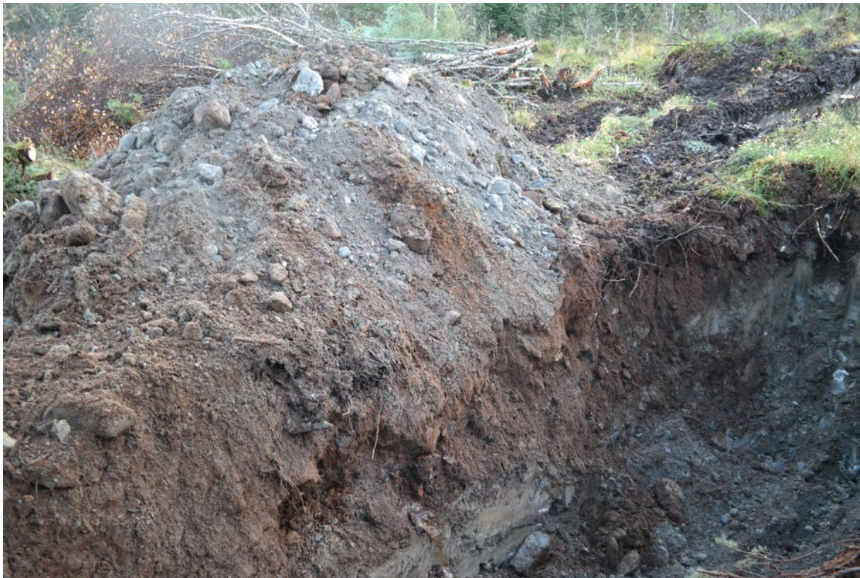
Figur 4 - Prøvegrop, DEP1 gravedybde ca. 2,0-2,5 meter
