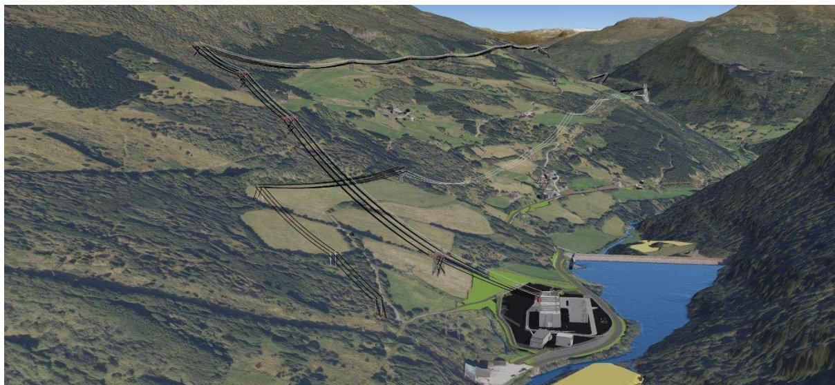
FIGUR 4 - OVRISDALEN, NY 420 kV LINJE (ØVRE) OG EKSISTERENDE 300 kV LINJE (NEDRE)
