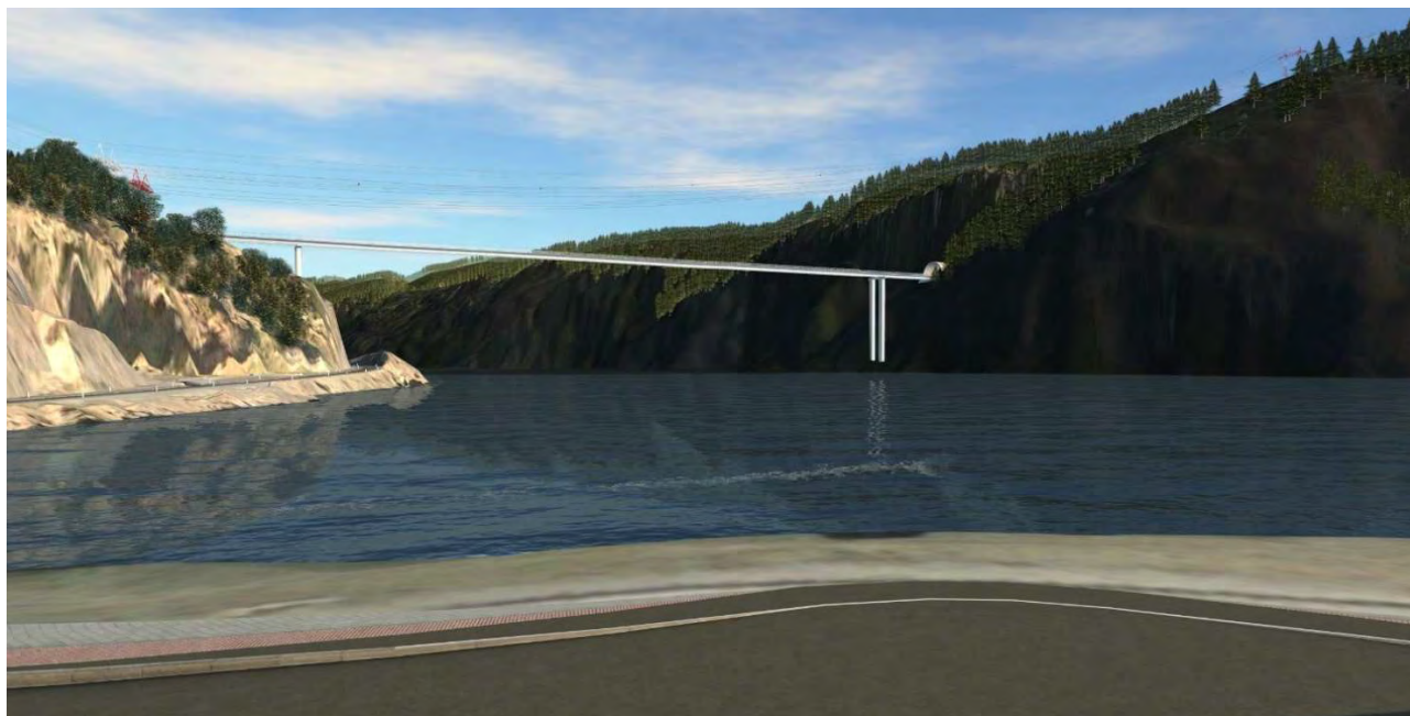
Figur 5-30. Modellbilde av alternativ 2.0/2.1 + A som krysser Fedafjorden. Ny E39 krysser Fedafjorden med bru. Fremstillingen av bruene er ikke endelig utforming, men er ment å illustrere bruens plassering i landskapsrommet
