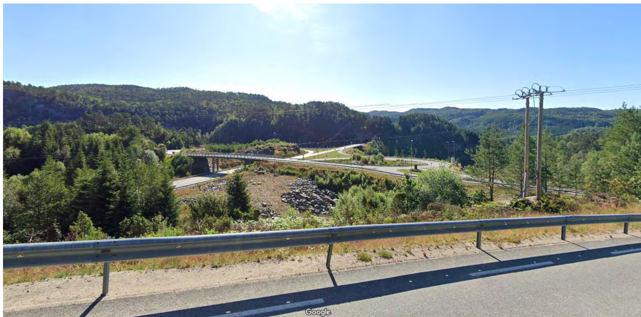
Figur 4-8. Krysset ved Oppofte der E39 og fylkesveien møtes. Bildet er hentet fra Google Street View
