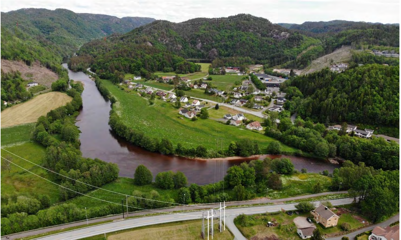
Figur 5-10. Strekskisse av alternativ 1.0 sett fra Lyngdal transformatorstasjon. Spennet over Lygna vil få hindermarkering for lufttrafikk.
