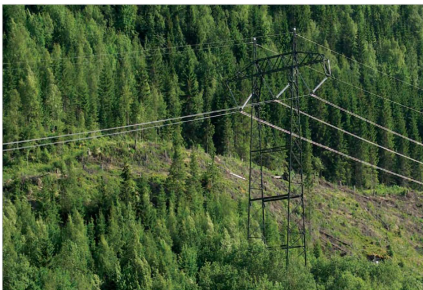
Figur 7-1. Mast malt i mørk farge harmonerer godt med en skogkledd åsside, her vist med gittermast (NVE, 2008)
