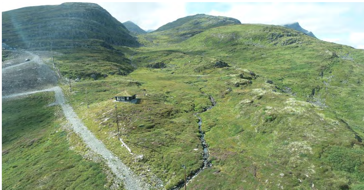
Figur 5-1. Aktuelt damsted før utbygging.
