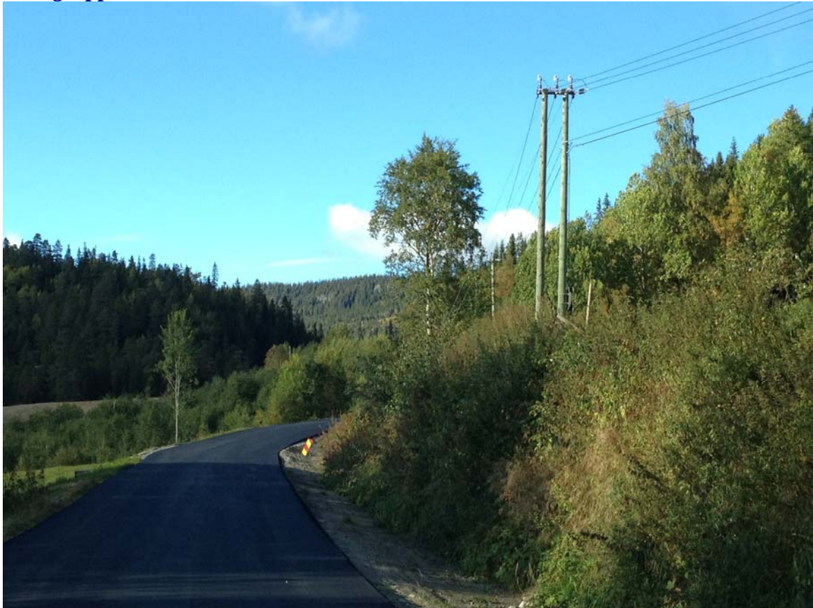
Bilde 1.1 Asfaltert vei opp dalen
