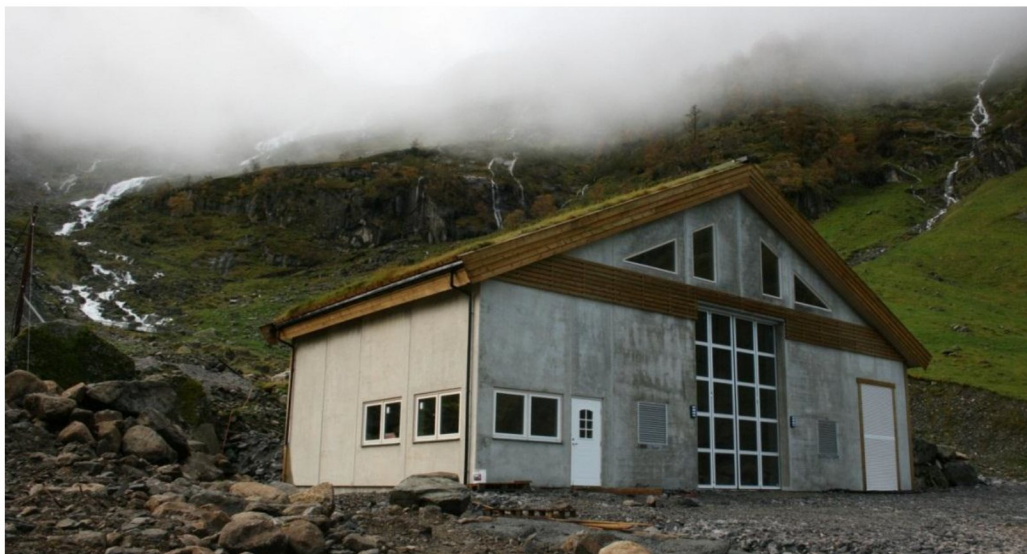
Figur 11 – Eksempel på en 5 MW kraftstasjon. Foto: Sofienlund, 2012
