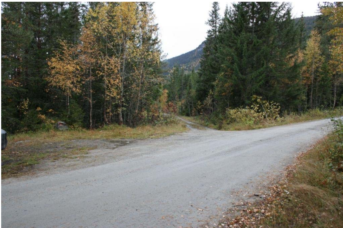
Bilde 4.2 Vei og avkjøring til kraftstasjonen
