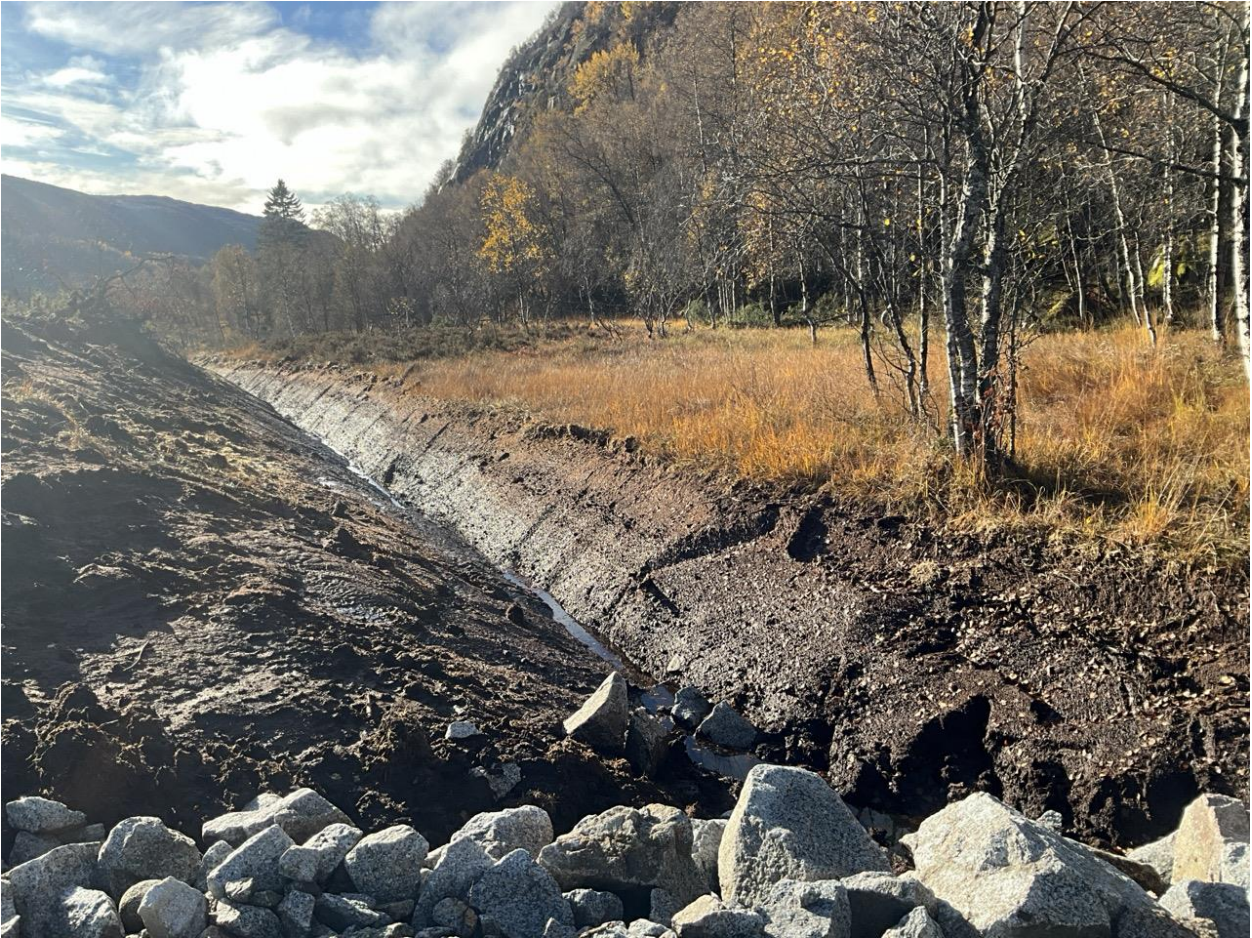
Figur 11: Sprengsteinsfylling inn mot grøft ved punkt #1
