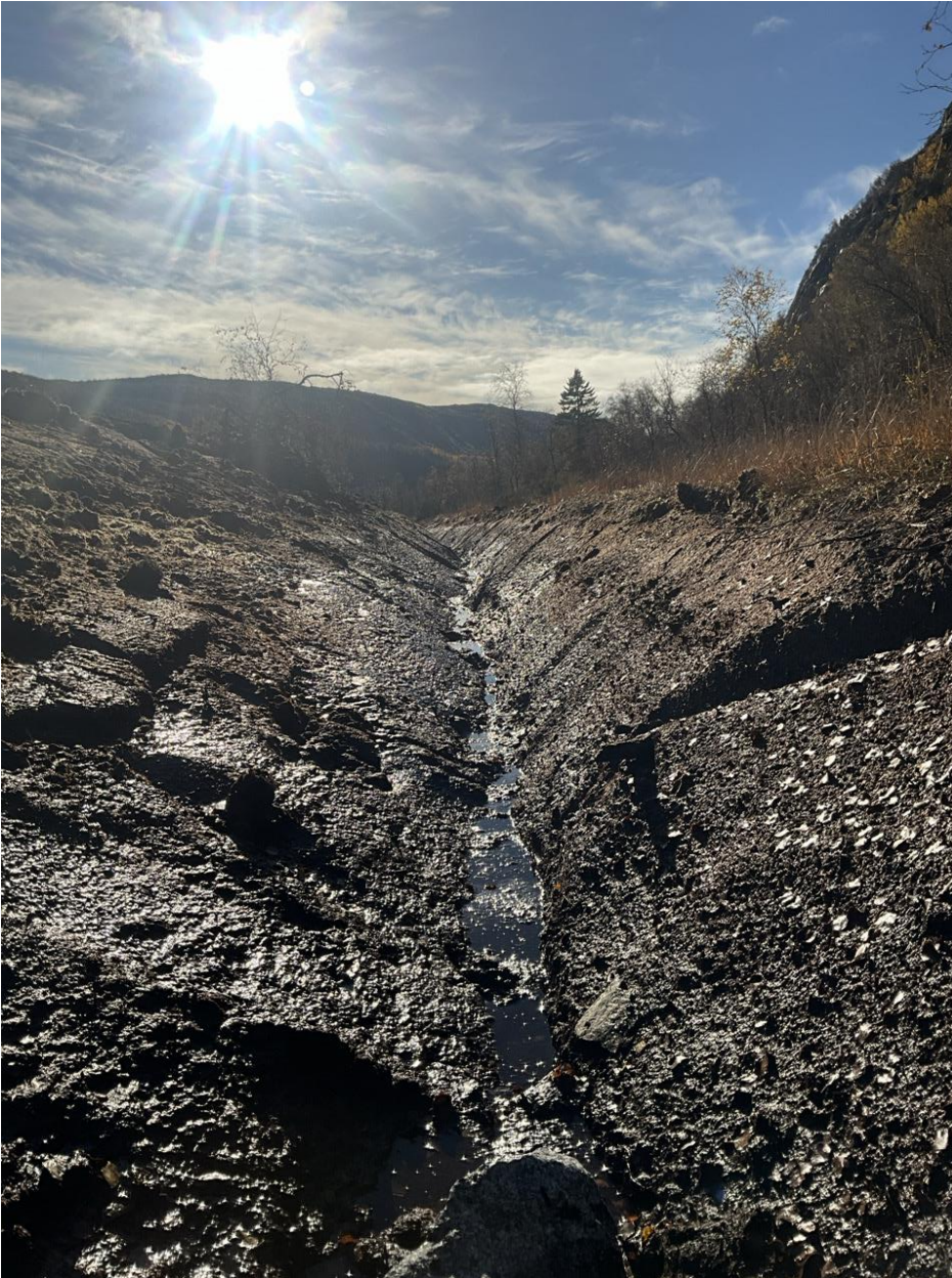
Figur 8: Grøft som går fra #1 til #3. Bilde tatt fra #1 i retning #3
