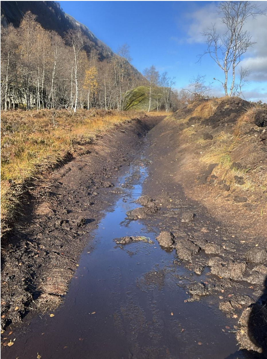
Figur 7: Grøft som går mellom punkt #1 og #3. Tatt fra #3 i retning #1.
