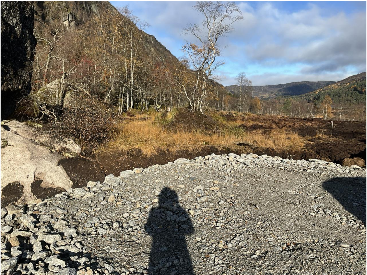
Figur 10: Anlagt snuplass ved punkt #2 med sprengstein og pukk
