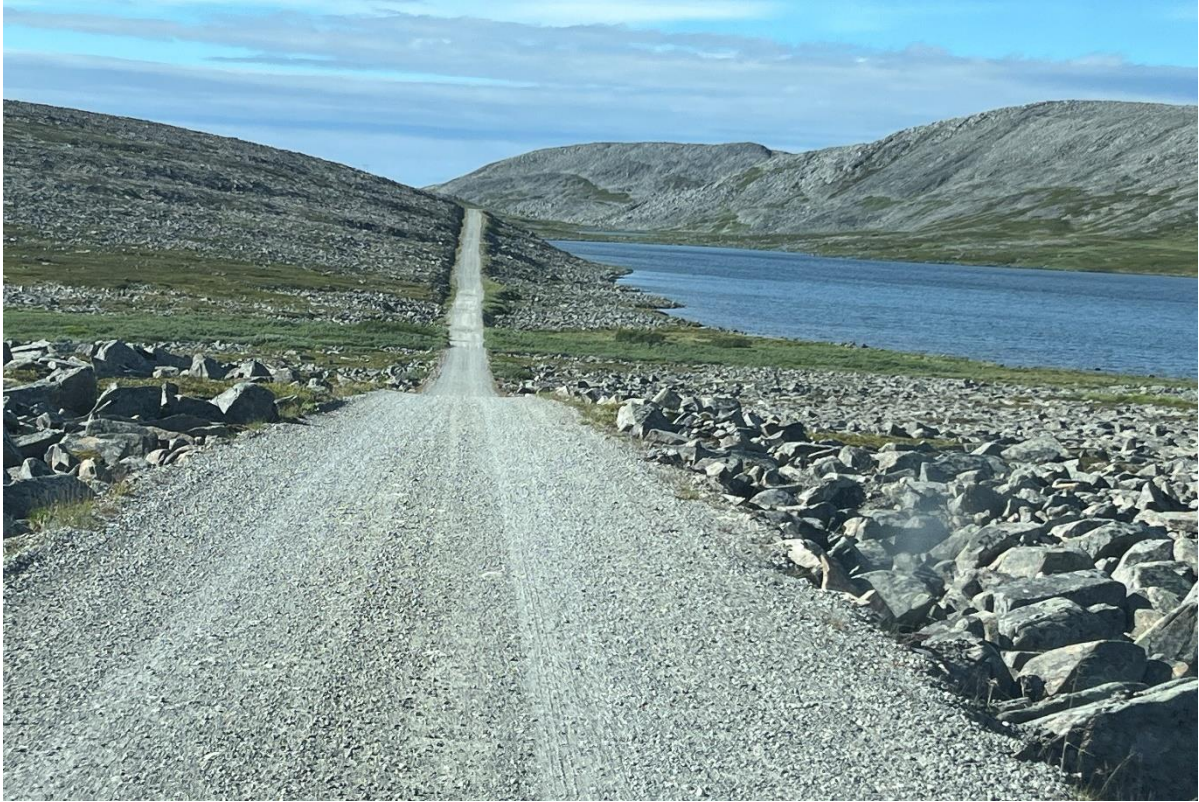
Figur 10 Viser dagens vei ved Storvannet inn mot planområdet
