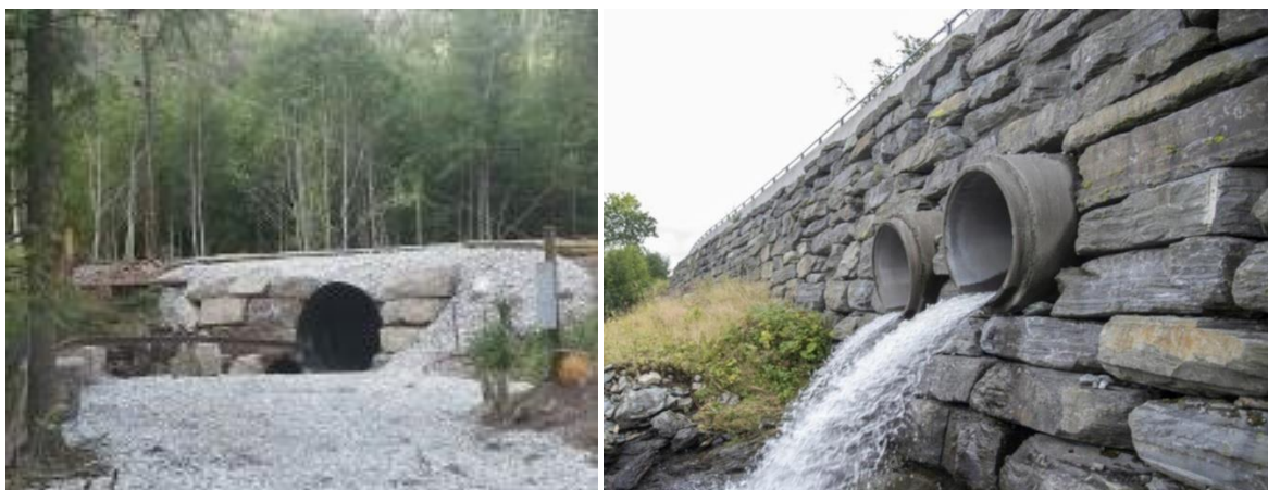
Figur 18 viser eksempler på natursteinmur ved bekkekryssing.
