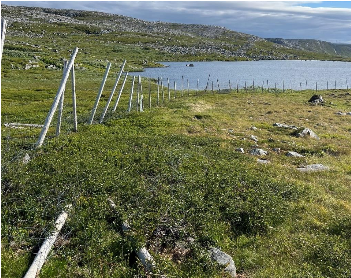
Figur 59 Viser deler av reingjerdet ved Finnskardet.
