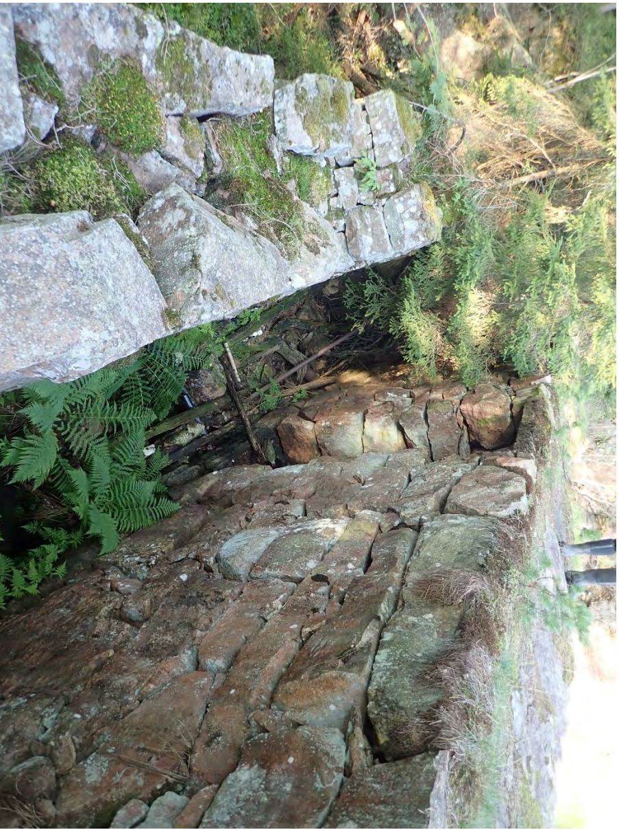
Figur 14. Sliss mellom murvanger uten filter.
