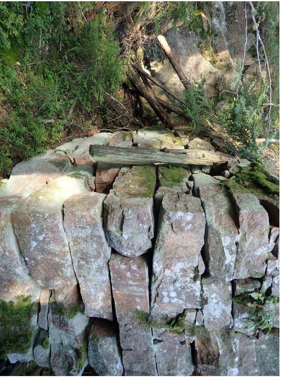
Figur 16. Mur konstruksjon nedstrøms.
