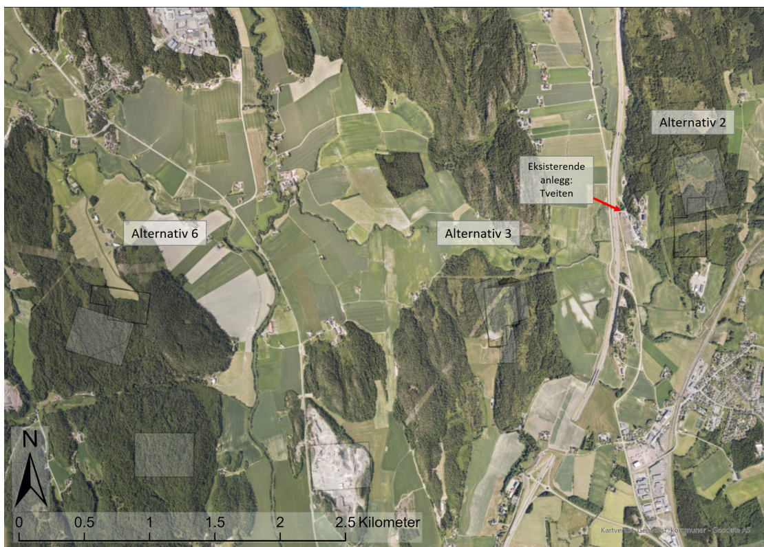
Figur 2 Flyfoto over området. Det er hogstfelt i, eller i umiddelbar nærhet av, samtlige trafostasjonsområder.
