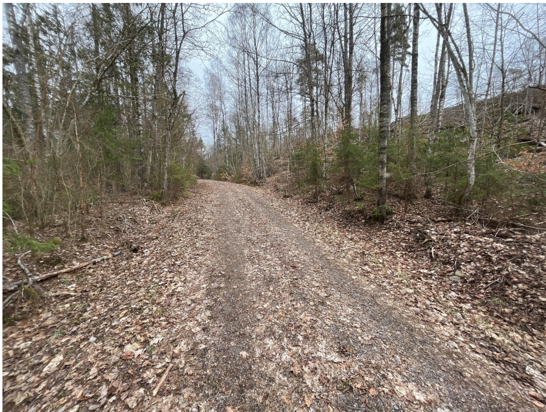
Figur 2-16 Mulig tilkomstvei nordøst for trafostasjon. Går via blokkig mark, stedvis med observert berg i dagen.
