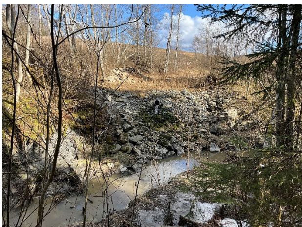
Bilde 38: Avslutning av oppfylt (sikret) ravine. Stor steinplastret skråning; to rør med rennende vann på østsiden av bekken. Merk: eksponert leire (overflateglidning) på venstre side av bildet. Sett mot øst.
