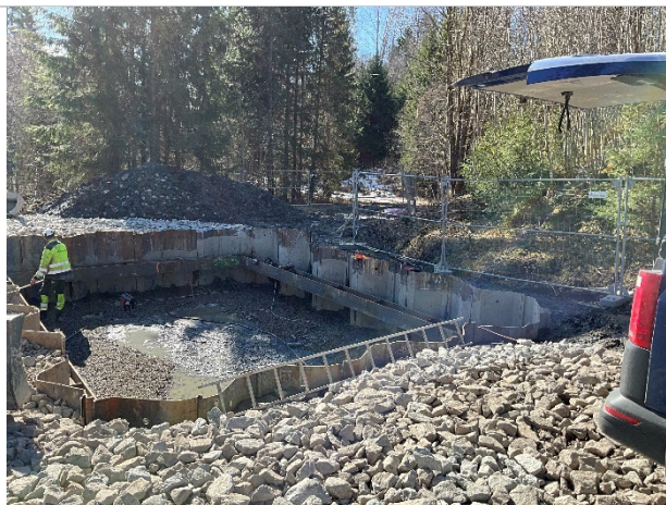
Bilde 25: Ny pumpestasjon under bygging.
