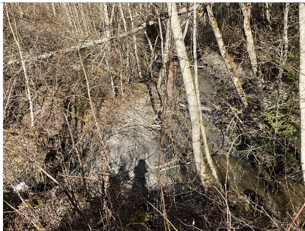
Bilde 33: Litt erosjon i bekken. Sett mot nord.
