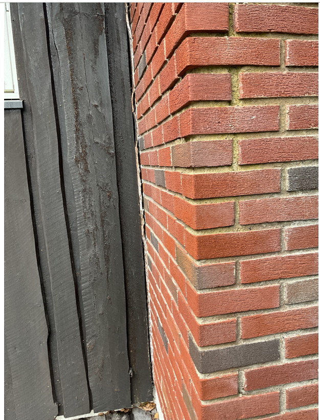
Bilde 17: Sprekk i konstruksjon mellom opprinnelig hus og tilbygg. 2023.
