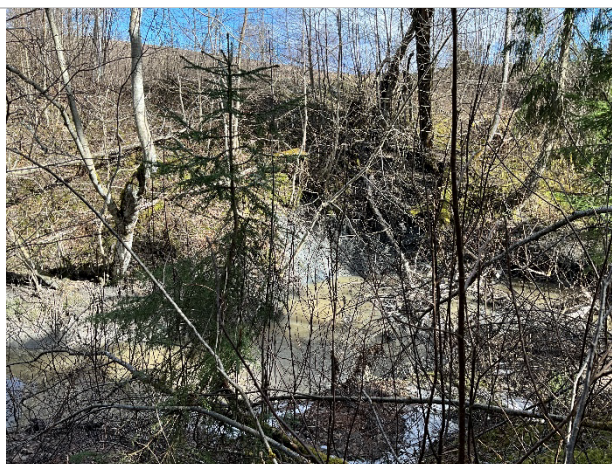
Bilde 39: Overflateglidning og noe erosjon i yttersving av bekken, på østsiden. Eksponert leire.
