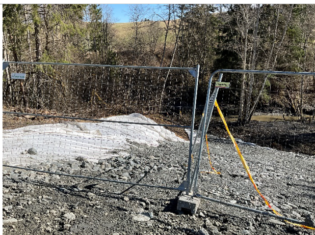
Bilde 26: Det er lagt ut stabiliserende motfylling mellom pumpestasjon og bekken.
