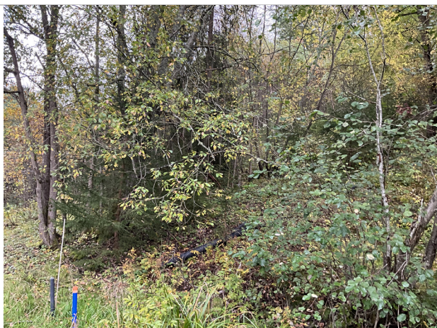
Bilde 3. Skråning mot Skibakkveien 12, sett mot sørøst
