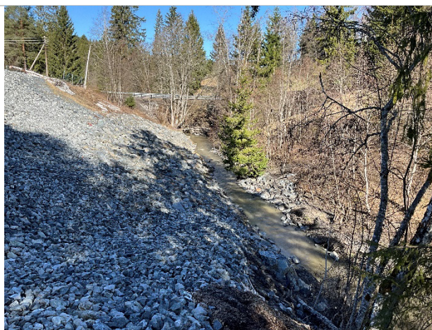
Bilde 21: Steinfylling og plastring i skråningen nedfor driftsbygget ved Egnerveien 45. Sett mot nord/veikulvert.
