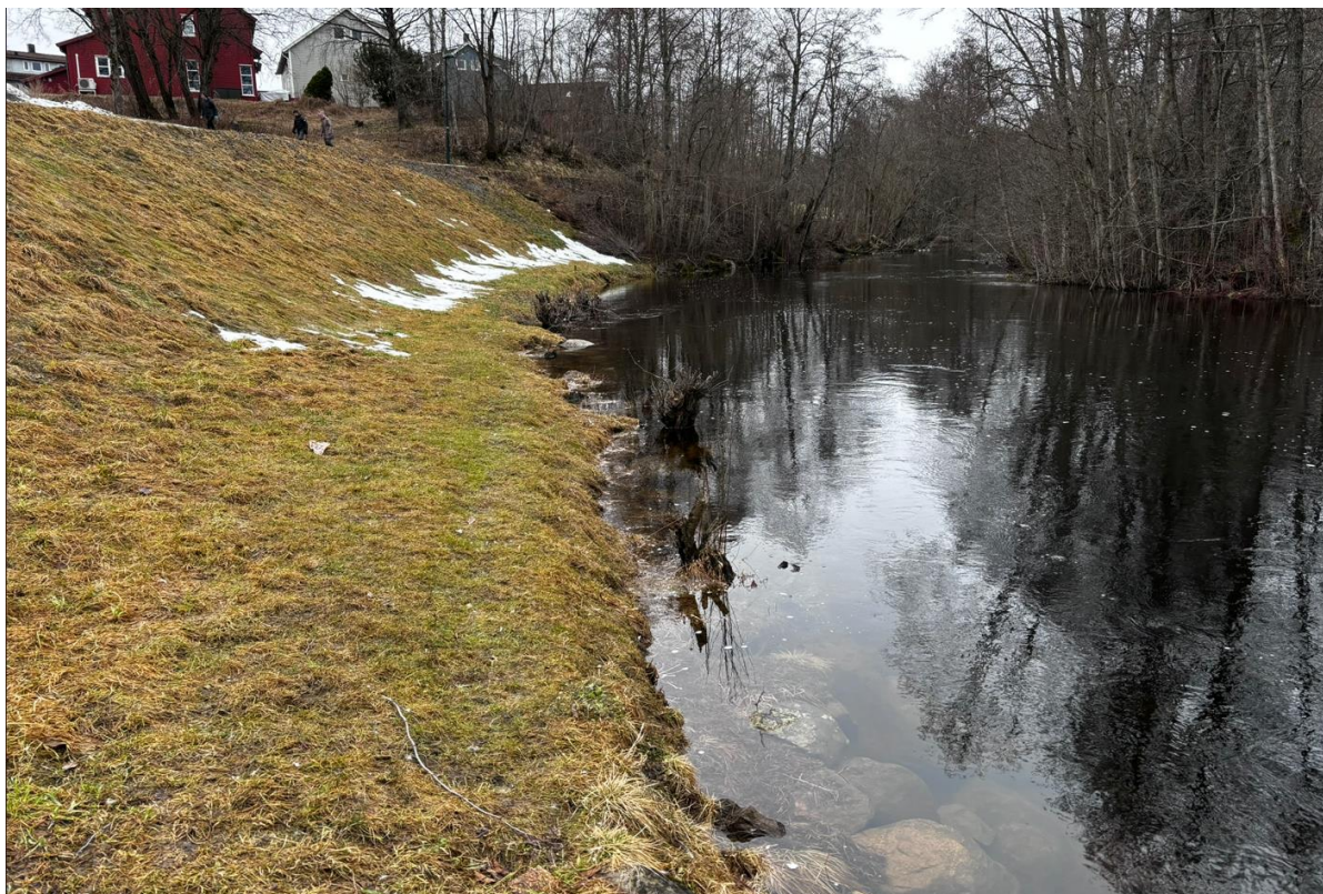
Figur 6-11 Eksisterende erosjonssikring langs Akerselva ved innersving. Bilde tatt mot sør.
