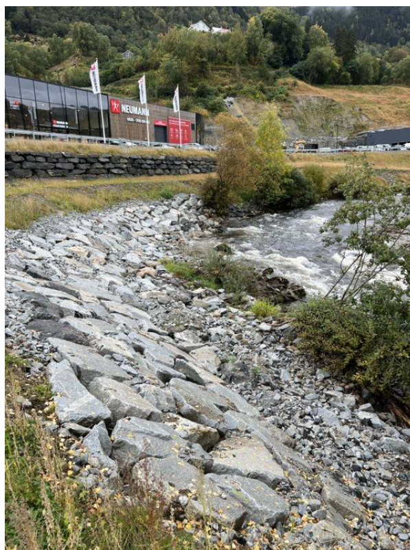
Figur 2. Eksisterende plastring sett ovenfra (venstre) og nedenfra (høyre). Overflaten er relativt ru i øvre del og er hele veien trukket noe inn ved normal vannføring i elven. Enkelte steder er noe av kantvegetasjonen bevart foran plastringen.
