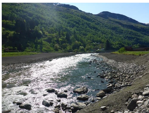
Figur 4. Eksempel på stein lagt ut langs elvebredden foran sikringsfoten (Bilde hentet fra Sikringshåndboka, NVE 2021 ).
