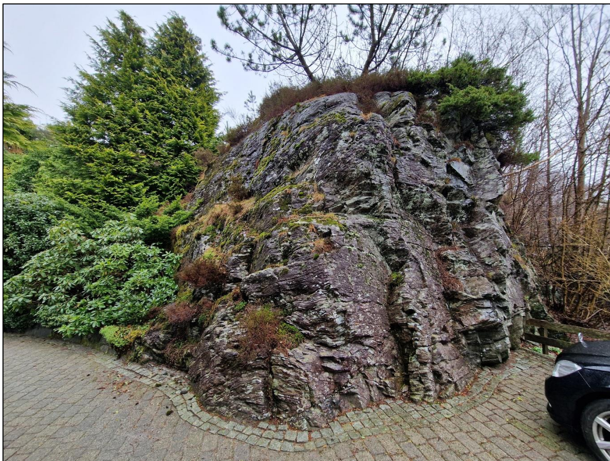
Figur 7. Bilde av bergskrent i sør. Bildet tatt mot sørøst.
