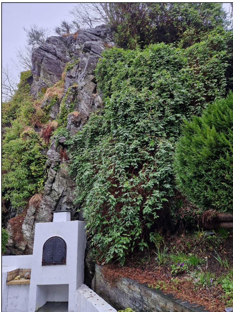
Figur 9. Bilde av bergpartiet i nord og nordøst. Bildet tatt mot nord.
