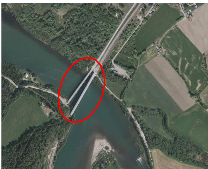
Figur 1-3. Eksisterende fylkesveg- og jernbanebru over Gudbrandsdalslågen ved Ringebu. Bruene er markert med rød sirkel. Randklev vegbru er til venstre.
