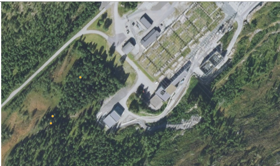
Kart 3: Forekomster av gubbeskjegg og nubbestarr ved transformatorstasjonen. Kilde: Miljødirektoratets Naturbase.
