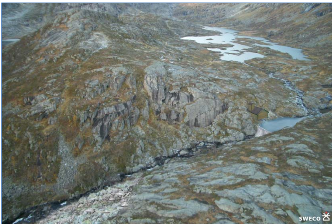
Bilde 1. Jotind 2 kraftverk og inntak til Jotind 1 kraftverk. Tippmasser fra tunnelen mellom Spannbogvatn og Jotind 2 kraftverk er plassert nede til venstre i bildet. (Illustrasjon: Sweco AS)
