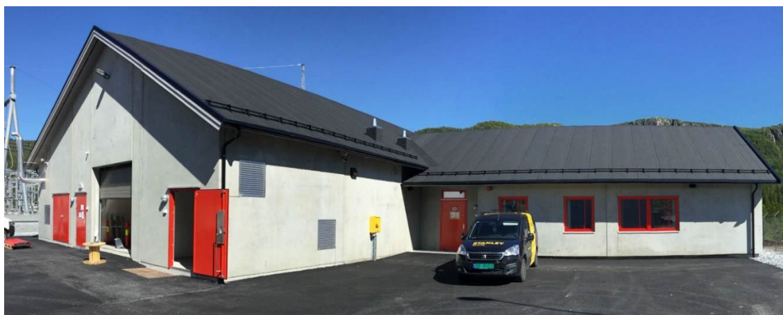
Figur 6: Eksempel på et Statnett standard kontrollhus, her fra Hofstad transformatorstasjon
