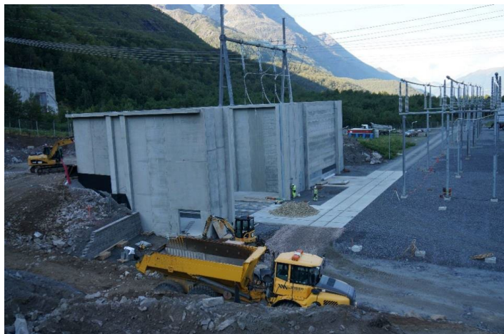
Figur 7: Eksempel på transformatorsjakt i betong
