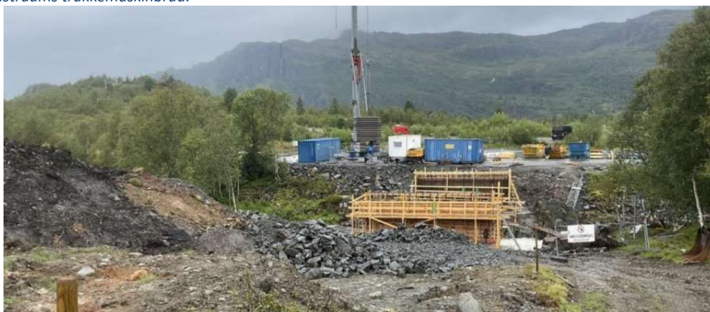
Figur 1-7 Ny bru over Storelva 200 m nedstrøms dammen i Stølselva. Bygd i 2024 av Statens Vegvesen. Brua ligg 65 m nedstrøms trakkemaskinbrua.
