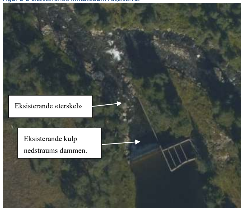
Figur 2-2 Eksisterande inntaksdam i Stølselva.
