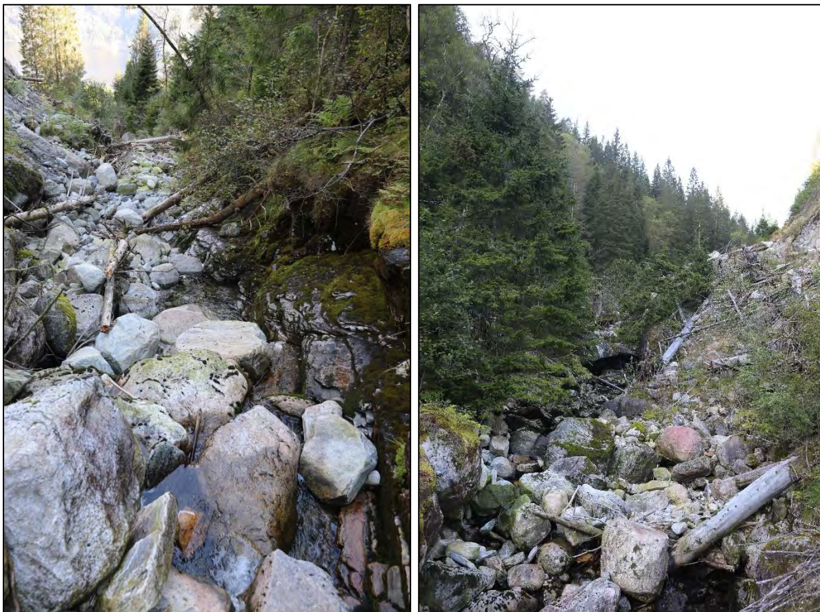
Fig. 26. Botna der anleggsveien har nærføring, sett nedover (venstre) og oppover elveløpet (høyre). Anleggsvei opp til høyre. 2. sept. 2022. Foto: A. Håland.
