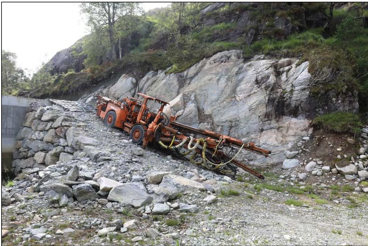
Fig. 7. Bildet viser området for tunnelpåhogg ved eksisterende inntaksdam i Nottveit kraftverk. 2. sept. 2022. Foto: A. Håland.
