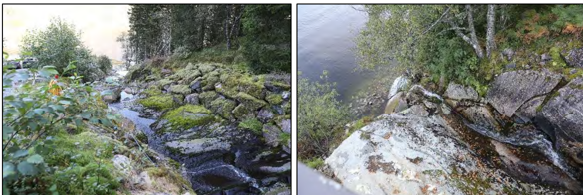
Fig. 29. Det nederste avsnittet av Botna, nedenfor riksveien, er forbygd med stor stein på begge sider av elveløpet. Utløpet i sjø (bilde til høyre) er utført et bratt, ca 10 meter høyt berg, et effektivt hinder for oppgang av fisk. 2. sept. 2022. Foto: A. Håland.
