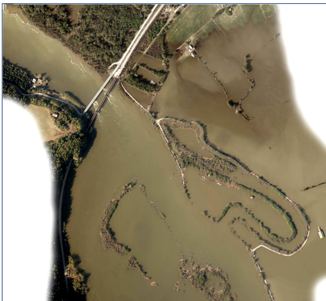
Figur 6. Flom ved Randklev 2. mai 2018 kl. 10:00. Vannføring målt til å være 2244 m 3 /s. Foto: Kartverket.
