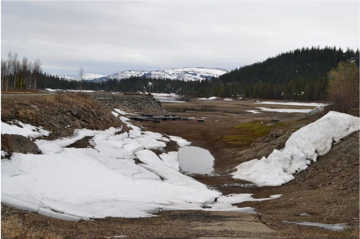
Nedfarten til havneanlegget i Rørvika den 20.05.2019. Vannstand 412,10 = LRV + 3,10
