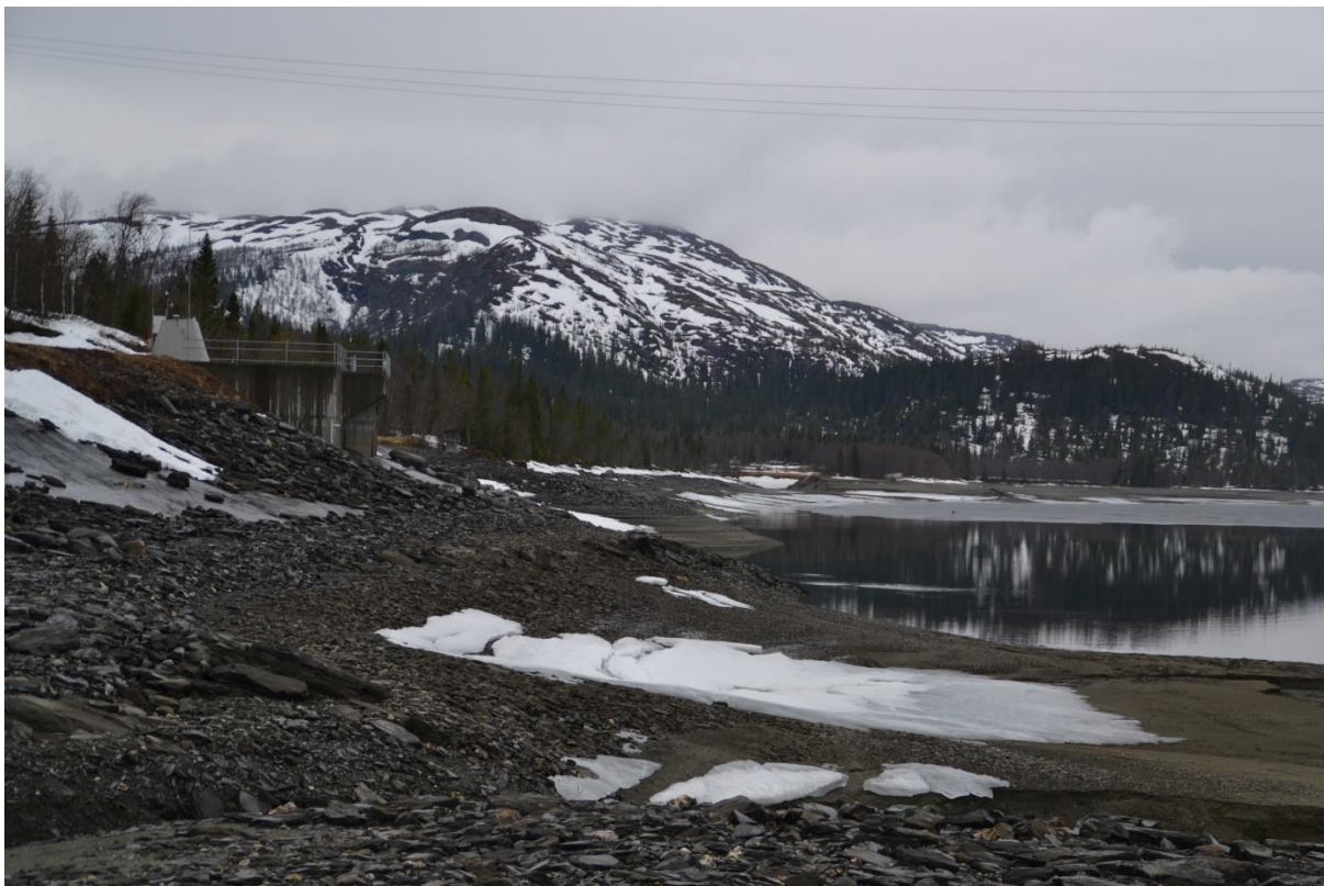
Tunnelinntaket til Linnvasselv kraftstasjon den 11.05.2018. Vannstand 410,21, eller 121 cm over LRV.
