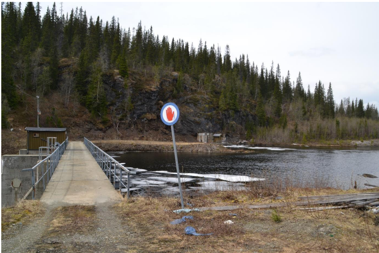
Adkomsten til dam og tunnelinntak ved utløpet fra Vekteren. Bilde tatt 22.05.2018
