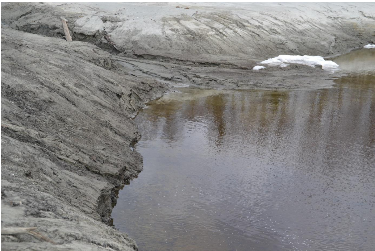
Det er ikke noe igjen av den opprinnelige strandsonen/sjøbunnen i Slåttvika, 16.05.2018.
