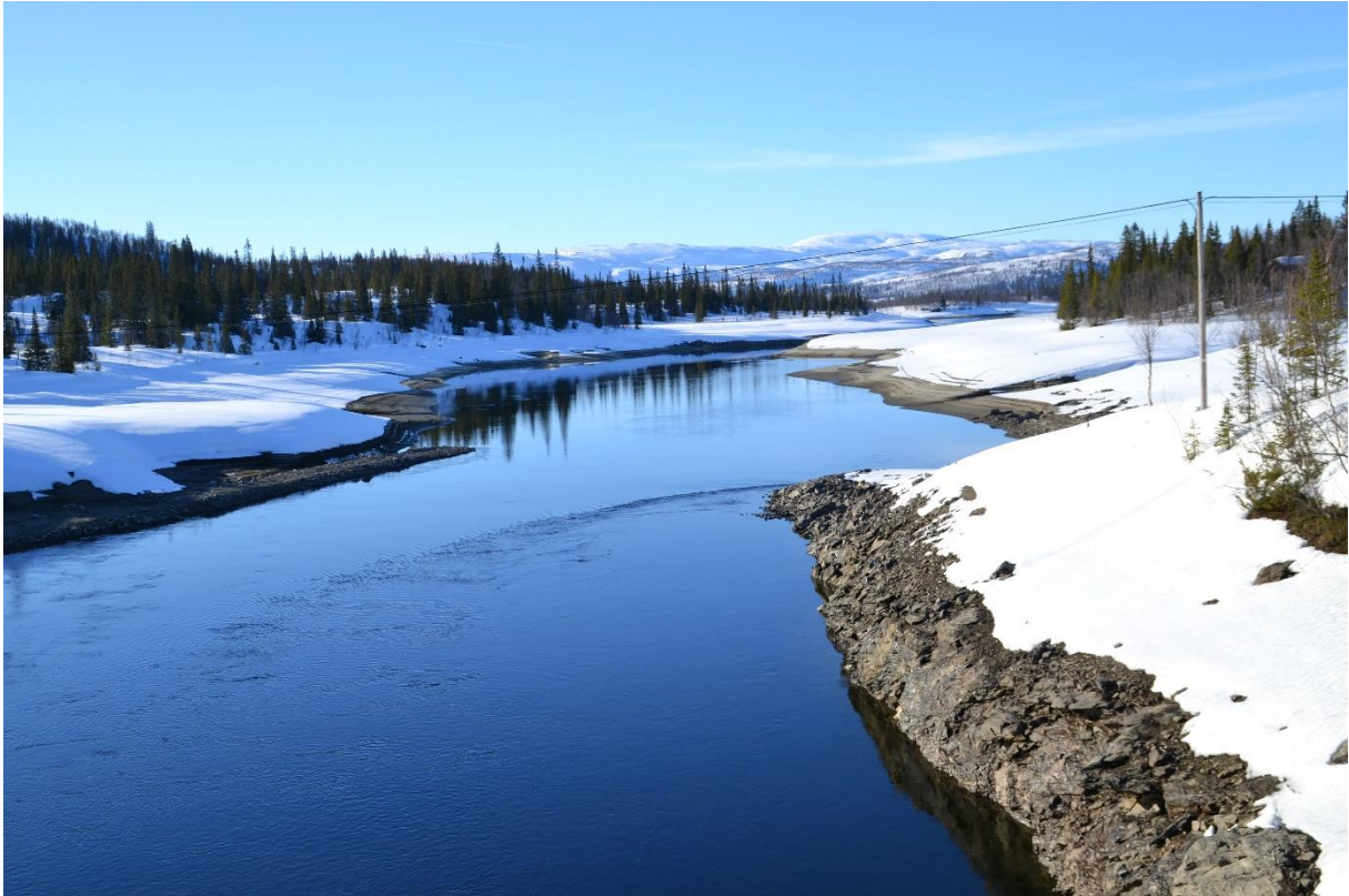
Situasjonsbilde fra Vekterhovden sett fra utløpskanalen og nordover, den 15.04.2019.
