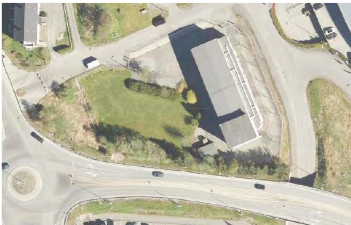
Figur 1: Eksisterende situasjon Hemmingstad transformatorstasjon, finn.kart
