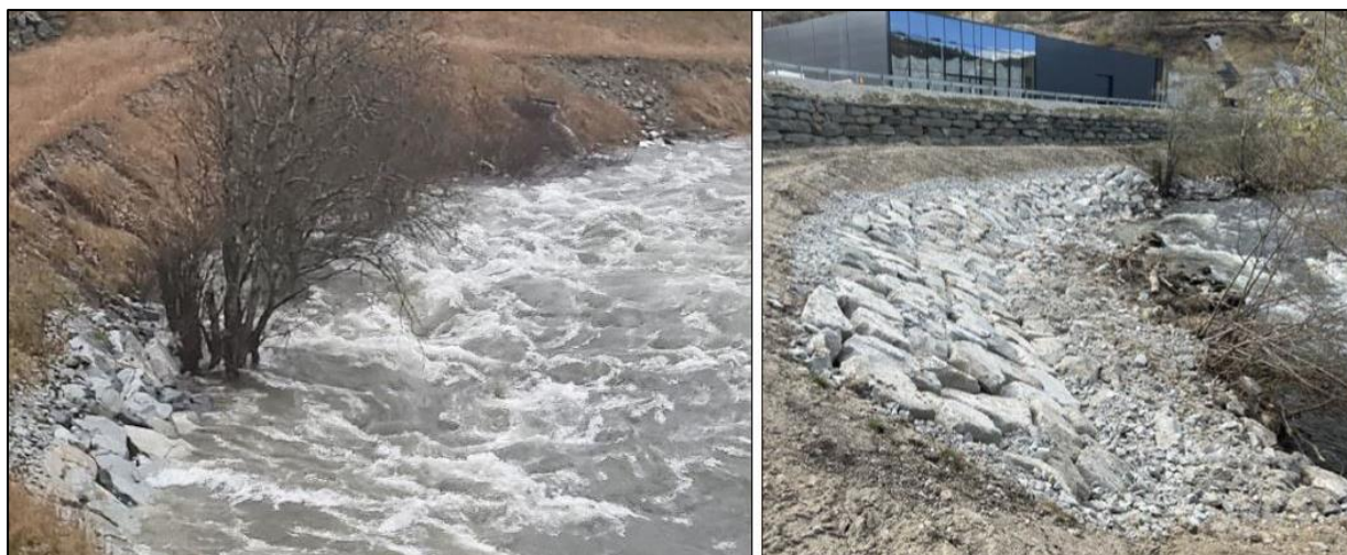
Figur 11 Bilde til venstre viser en flomsituasjon fra 2022. Bilde til høyre viser dagens erosjonssikring. Kilde: Sweco, 2023
