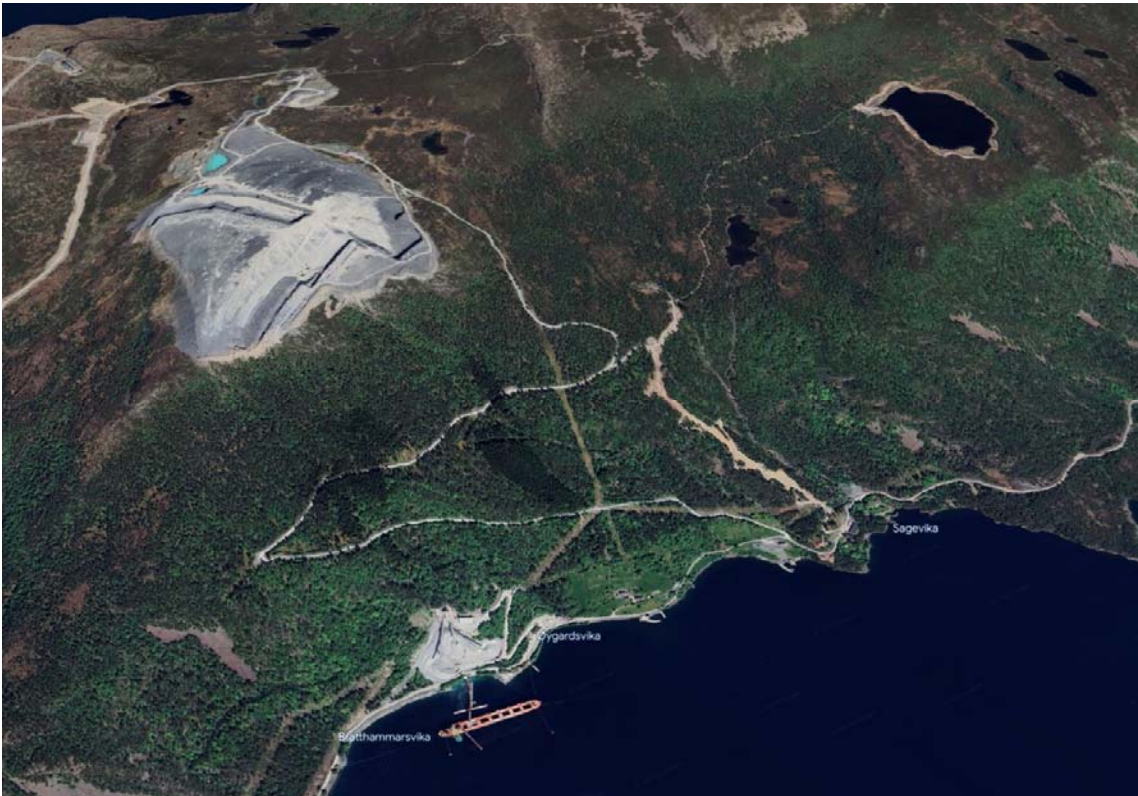
Bilde 1: Dyrstad området med Dyrstadvatn oppe i høyre hjørne, Bremanger Quarry sine anlegg i venstre kant og ny rørgate Dyrstad kraftverk midt i bilde.
