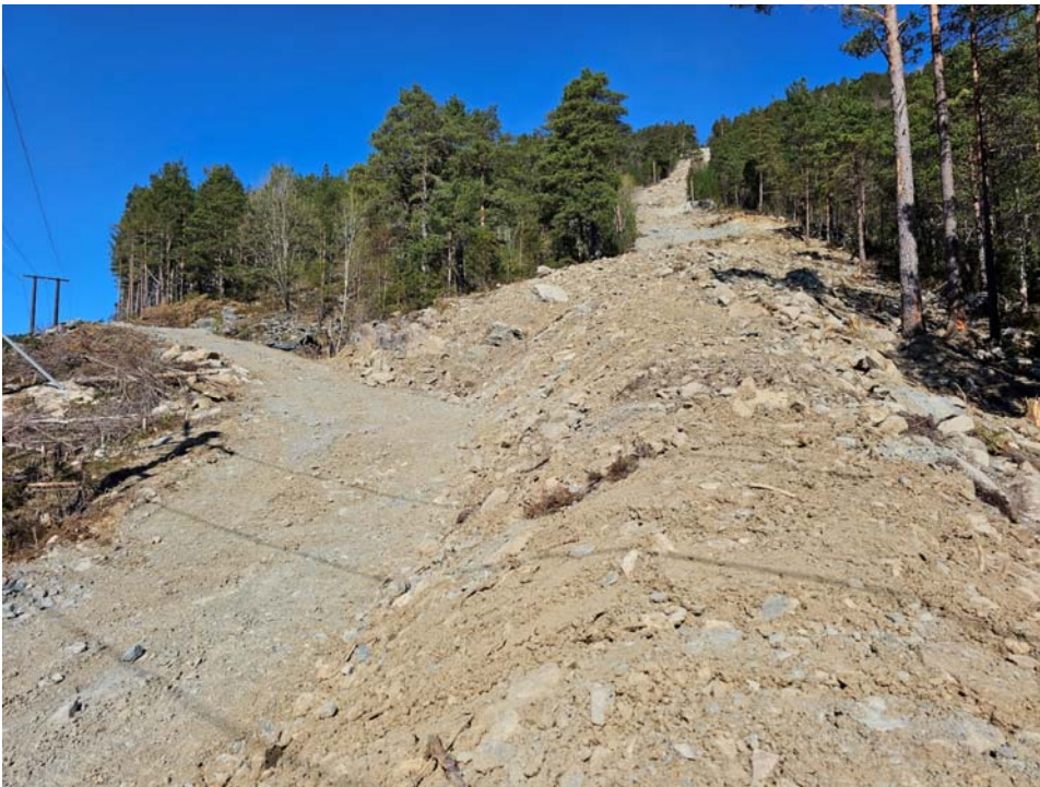
Bilde 4: Rørtras rett ovenfor kraftstasjon. Bilde fra 2023 når anlegg nettopp var ferdig.
