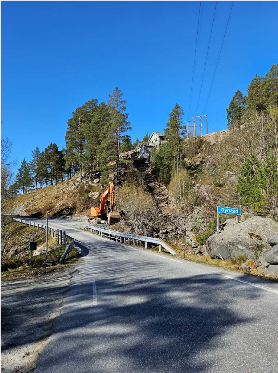
Bilde 5: Brua over Dyrstadelva. Kraftstasjon oppe på kanten og avløpet fra denne ned mot elva. Det vurderes som et alternativ å legge nytt rør ned mot ny kraftstasjon i deler av denne traseen og krysse veien bak der gravemaskin står. Alternativet er å gå rett ned den bratte bakken fra kraftstasjonen og krysse veien lenger bak.
