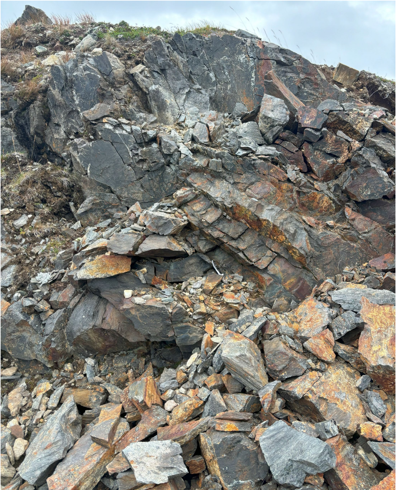
Figur 7: Tett til middels oppsprukken bergmasse med teikn til deformasjon og folding, samt rust og mørk farge på overflater.
