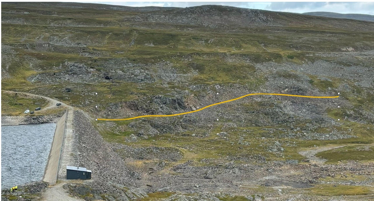
Figur 9: Oversikt vestsida av dammen. Det er tatt ut massar langs anleggsvegen som er vist med oransje strek.
