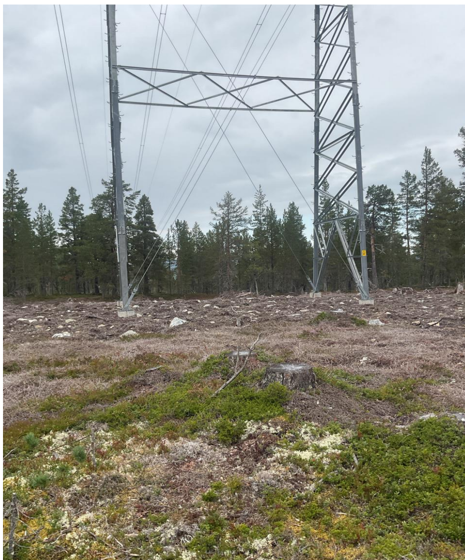
Bilde 3: Mastepunkt 87 på Frønningen viser god arrondering til omkringliggende terreng. På inspeksjonstidspunktet var det to år siden istandsettingen ble gjennomført, så revegeteringen tar tid i dette området. Foto: NVE.
