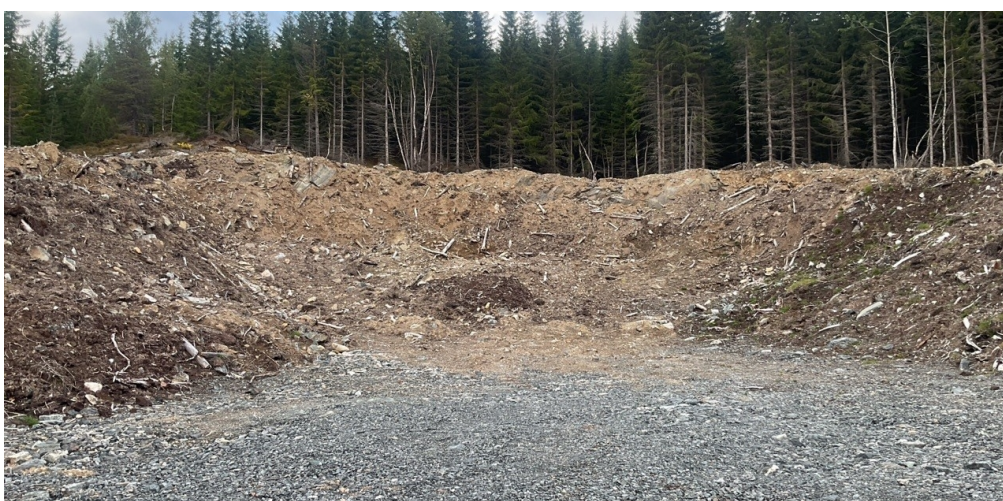
Bilde 8: Massetaket på Vetlareset som NVE mener ikke er lukket på en god nok måte. Foto: NVE.
