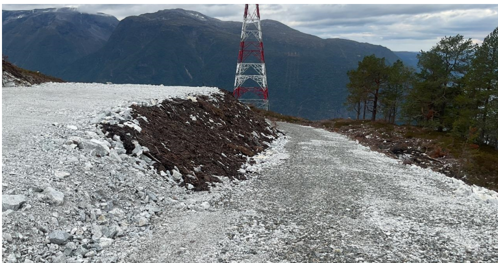
Bilde 5: På Fimreite er det benyttet relativt grove fraksjoner. Statnett opplyste at fyllingene er mettet med finere masser, og at vekstlaget har ligget én vintersesong. Foto: NVE.
