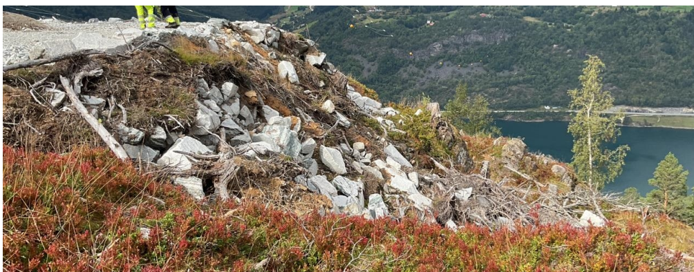
Bilde 6: På Vinestølen har steinmasser som er brukt til å opparbeide veg/riggplass rast ut i terrenget. Foto: NVE.
