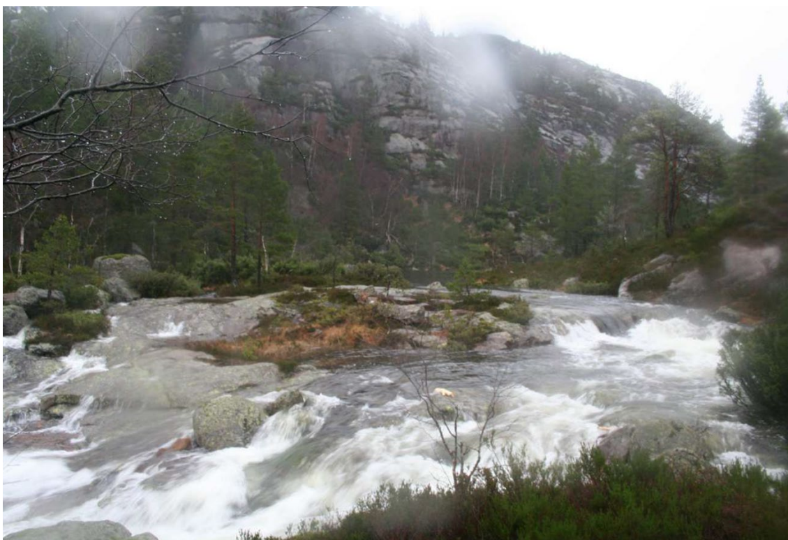
Inntaksområdet ved flom (Foto: Sirdalskraft AS januar 2007)
