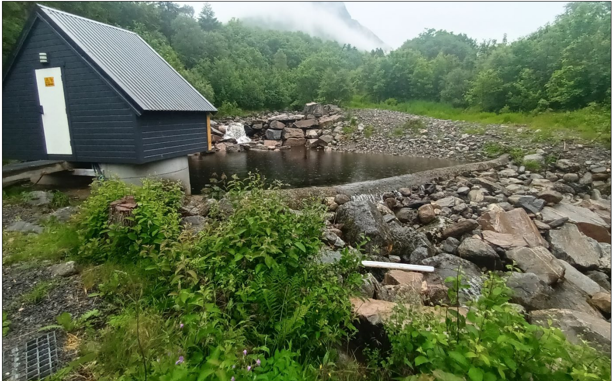
Figur 10: Bildet viser eksponerte løsmasser i elveløp ved sørlige grense til kartlagt område. Løsmassene her består av elveavsetninger og har tilført større blokker ifm. flomsikring langs elveløpet. Infopunkt 4.
