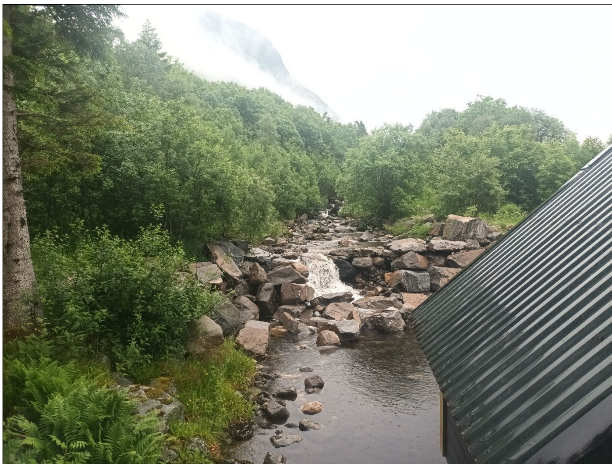
Figur 12: Bildet viser deler av elveløpet ved sørøstlige grense til kartlagt område. Elveløpet har fått tilført store steiner i nedre deler av elveløpet som erosjonssikring mot flom.
