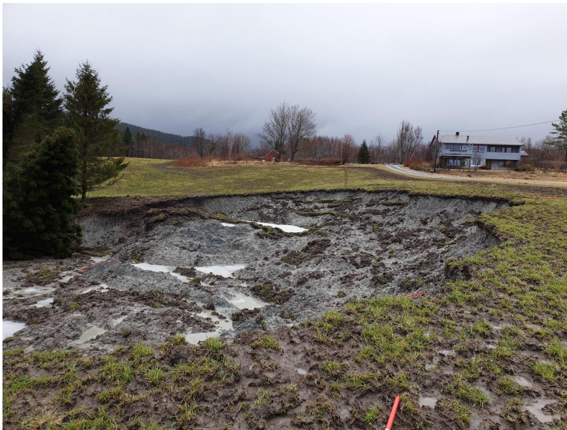
Figur 1-1 Skredkanten med bolighus i bakgrunnen, fotografert under befaring 18.02.2020
