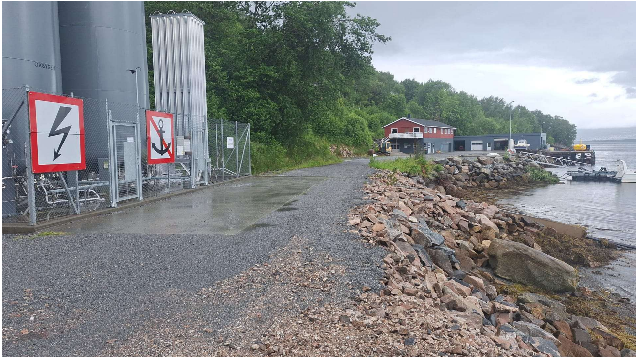
Figur 11: Farvannsskilt montert på Sekken netteier.
