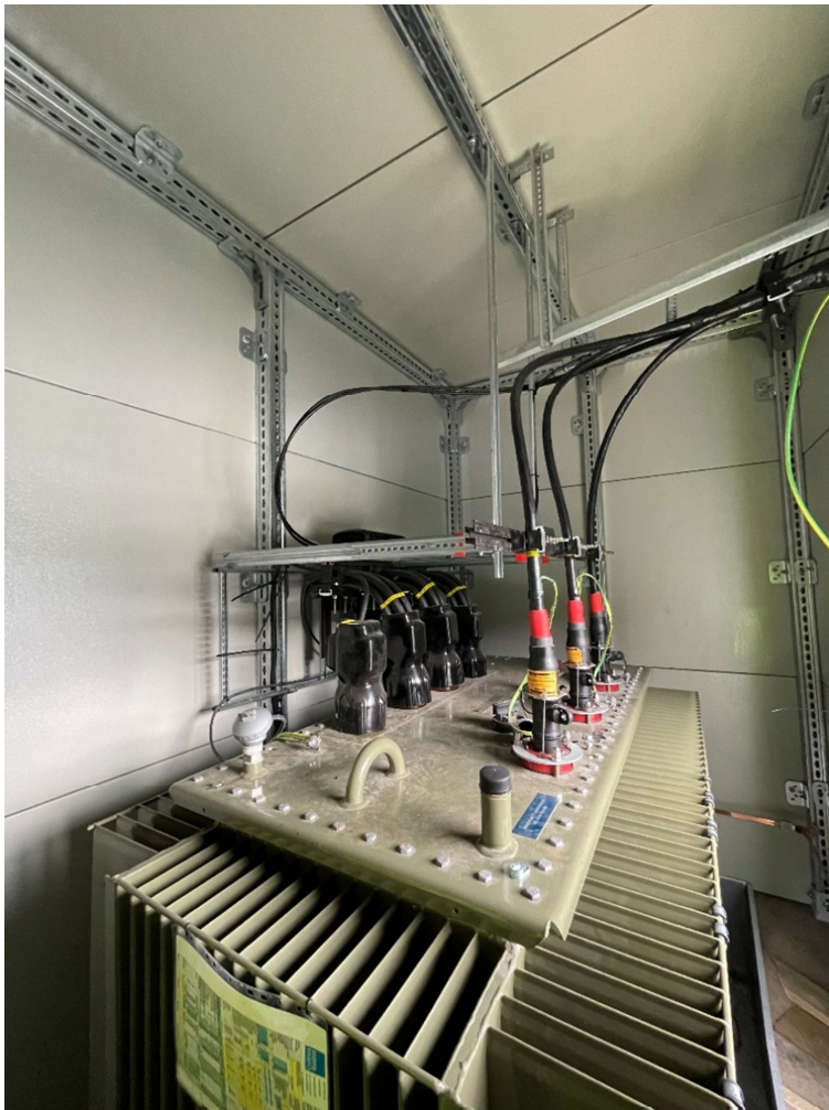
Figur 12: Distribusjonstrafo Seterneset
