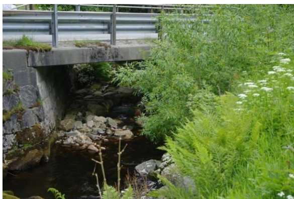
Figur 9. Bru som kryssar bekken nedanfor Tveito.
