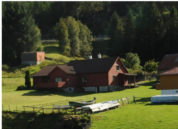
Figur 5-7. V ningsshus p  Vistvik er bygget ut i nyere tid, men har fortsatt trolig deler av den opprinnelige bygningskroppen bevart.
