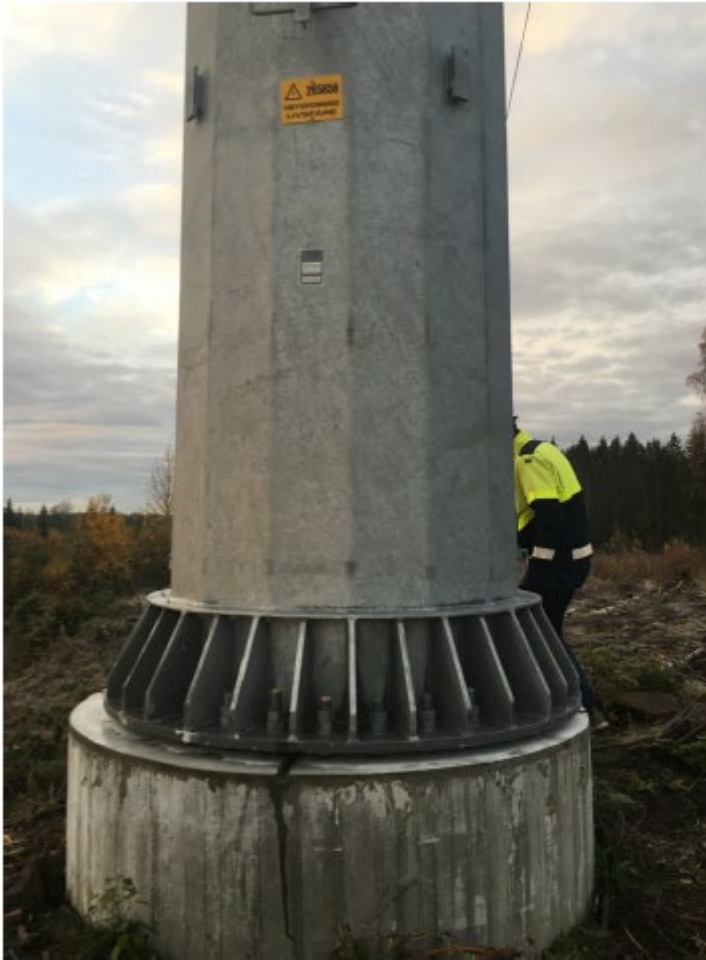
Figur 1: Bildet viser fundament med innfesting av samme mastetype som skal benyttes i prosjektet 132kV Åbjøra - Gjøvik
