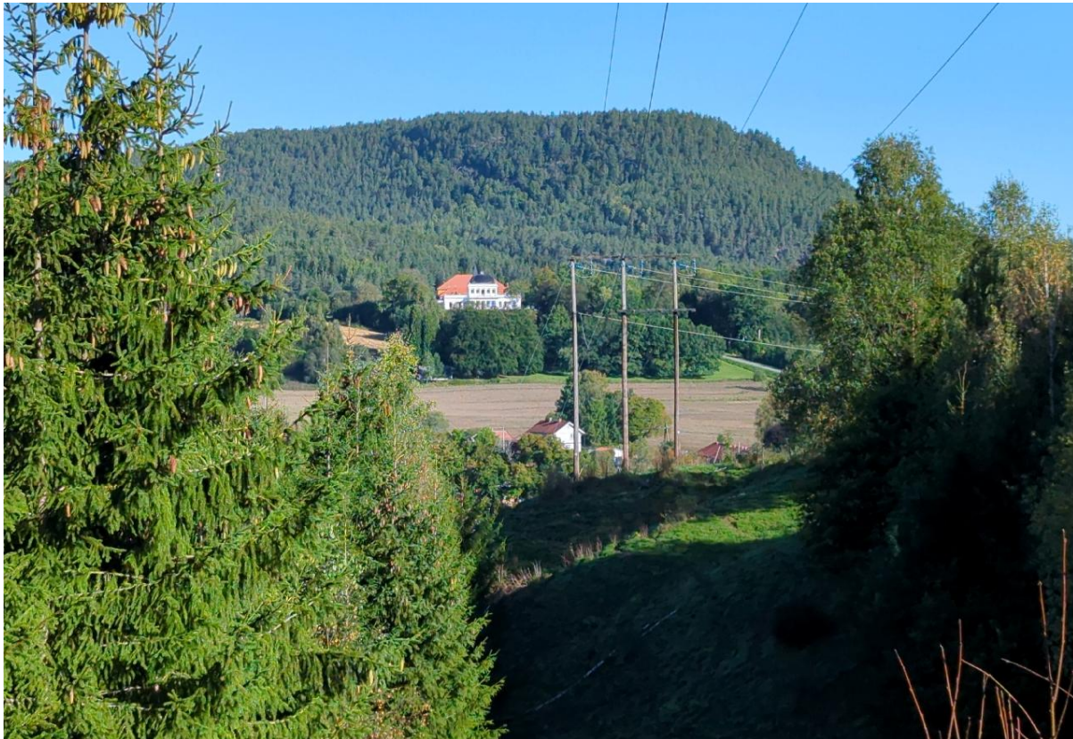
Figur 3-12. Bilde tatt fra Holla transformatorstasjon i retning Ulefos hovedgård. Hovedbygning sees i midten av bildet, med bruksbygning i bakkant. Lille Ulefoss er ikke synlig og er skjult av vegetasjon og topografi.
