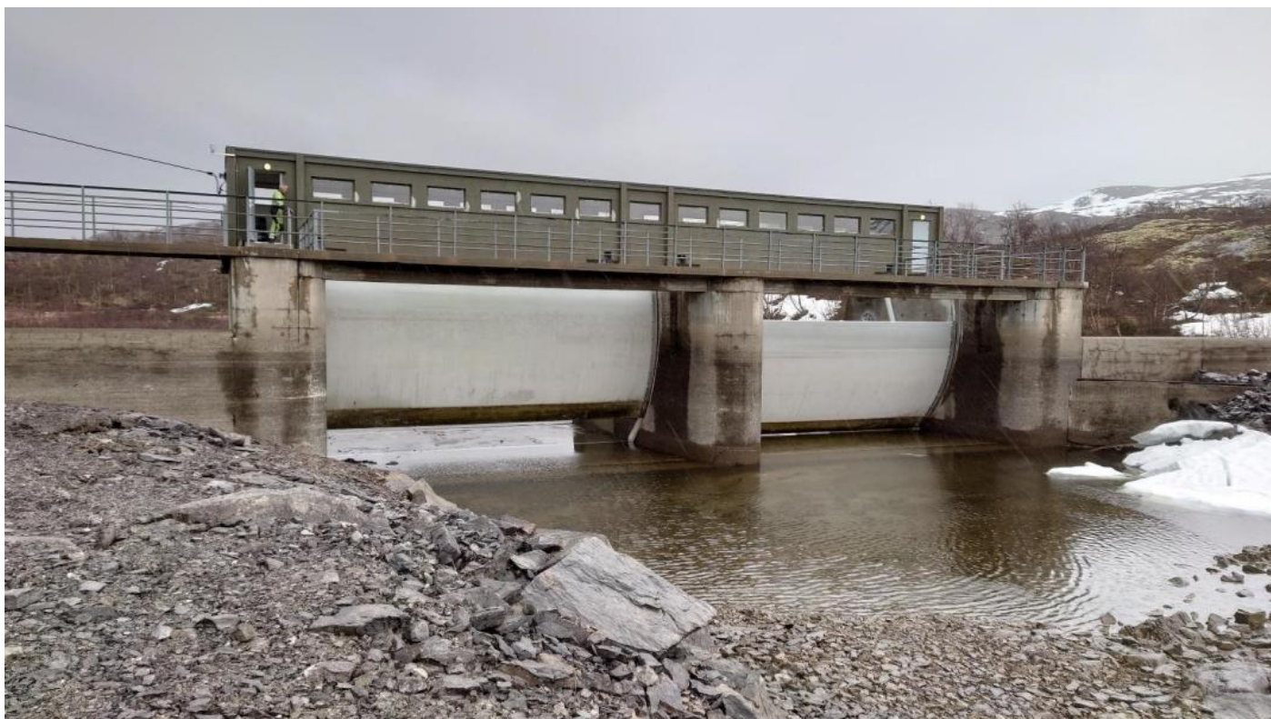
Figur 3. Foto av dam Ustevatn
