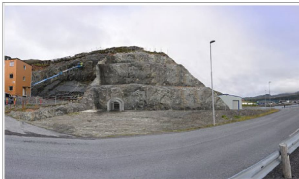
Figur 3-5 Overgang fra kabel i tunnel (stiplet linje) til sjøkabel (heltrukken linje) ved Meland. Planlagt skjæring 30 meter lagt i terrasser i fjellknausen. Stigen er vist som brunt område til høyre for Rossmollgata) Fotomontasje: terrenget før og etter ved tunellpåhugget i fjellknausen Stigen. Kilde: Multiconsult 2020/Equinor.
