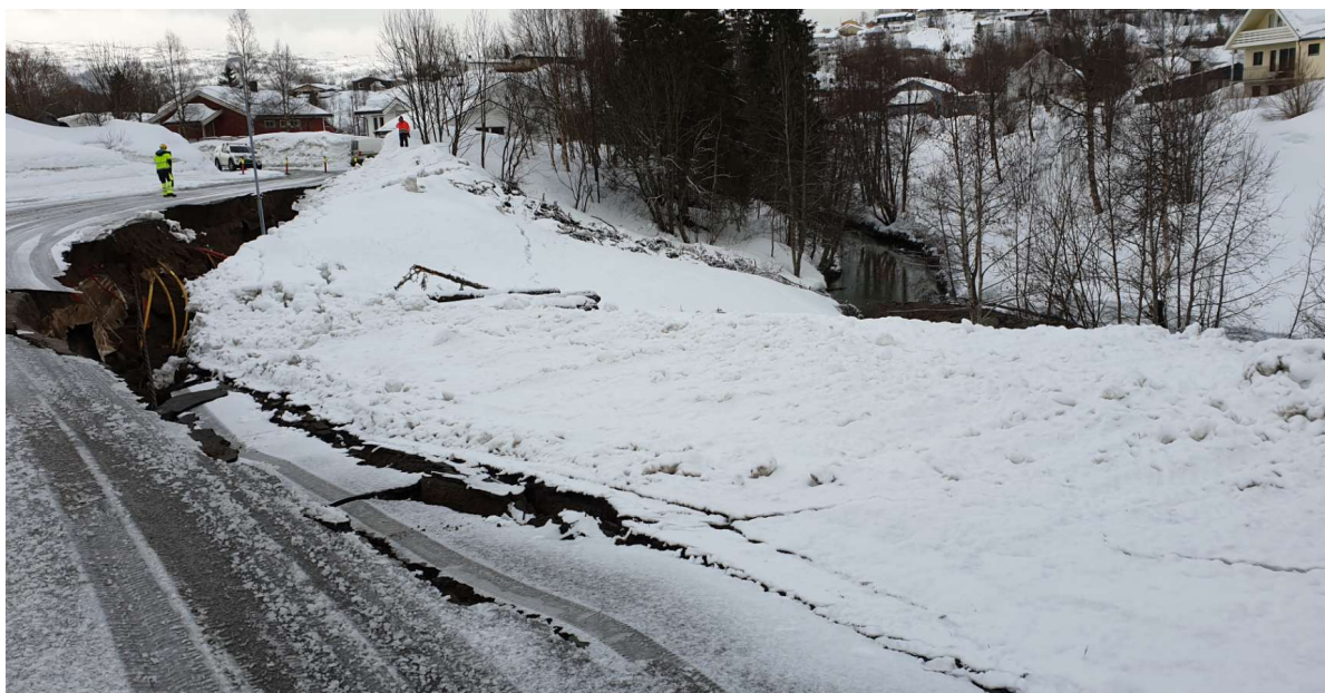
Figur 2: Bilde tatt ved befaringen på morgenen 15/4. Bildet er tatt fra nord mot sør. Skredkanten synes til venstre i bildet. Bak snøen til høyre i bildet skimtes Yttrabekken med nedre del av skredet.
