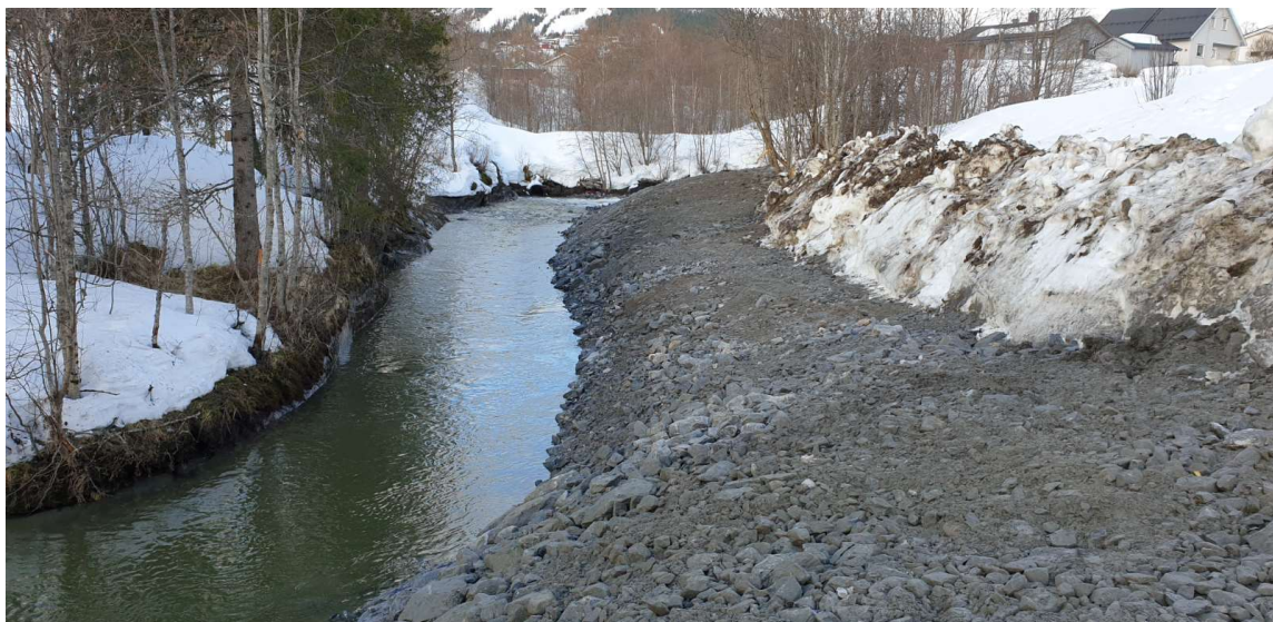
Figur 10: Bilde tatt i nederste del av bekken 24/4. Viser masser fra anleggsveien som er plassert til høyre for bekkeløpet. På venstre side av bekken er det berg i dagen. Bergterskelen i bekken er til høyre for svingen bakerst i bildet.
