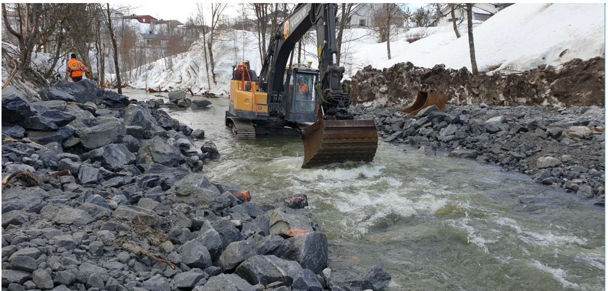
Figur 7: bilde tatt 21/4. Gravemaskinen i bildet holder på å etablere terskel. Steinen til venstre er stein til terskelen. Vannmengden i bekken har økt noe, og vanskeliggjør arbeidene.
