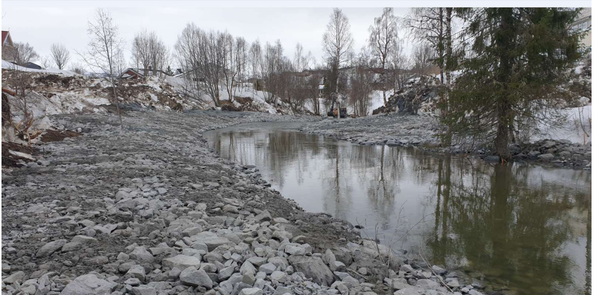
Figur 6: Bilde tatt 21/4. Steinmasser er ferdig innfylt i øverste del. Gravemaskinen i bakgrunnen holder på å etablere en terskel i bekken.
