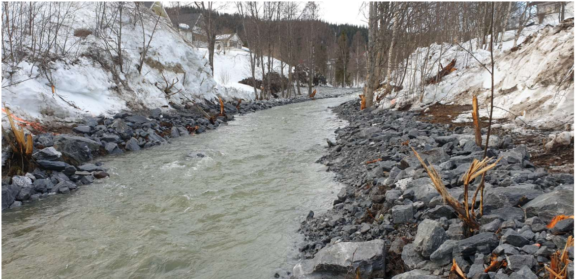
Figur 9: Bilde tatt 21/4 ved bergterskelen. Bildet er tatt oppover i bekken. Transportveien for stein er nå planert ut i bekken og i sidene. Øverst i bekken synes terskelen som ble etablert med stein.
