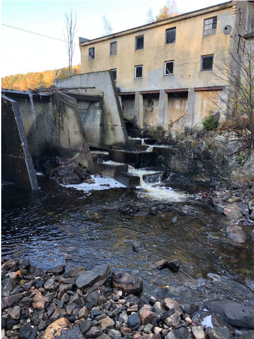
Figur 10 Øvre fisketrapp som leder oppvandrende fisk opp og over inntaksdammen til Fostveit kraftverk.
