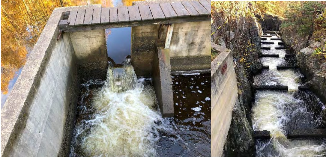
Figur 14 Nedre fisketrapp men innløpsåpning der det går 200l/s og til høyre fisketrappa med ca 200 l/s.
