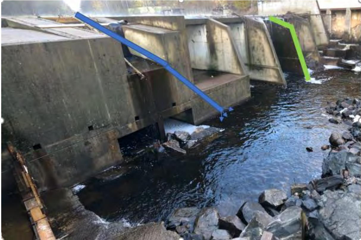
Figur 13 Eksempel på trase for en åleleder i blå farge, de små pilene antyder vannsprut som attraksjonsvann. Grønn farge trase for åleleder foreslått av Fiskelaget.
