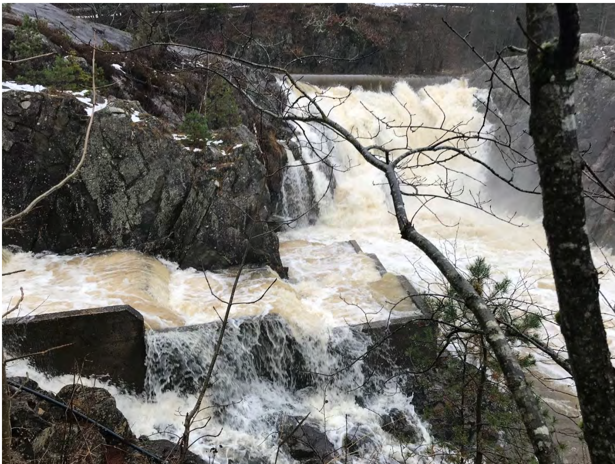
Figur 9 Fossstveitfossen med terskel og elva i flom. Nedre del av nederste fisketrapp til venstre i bildet.
