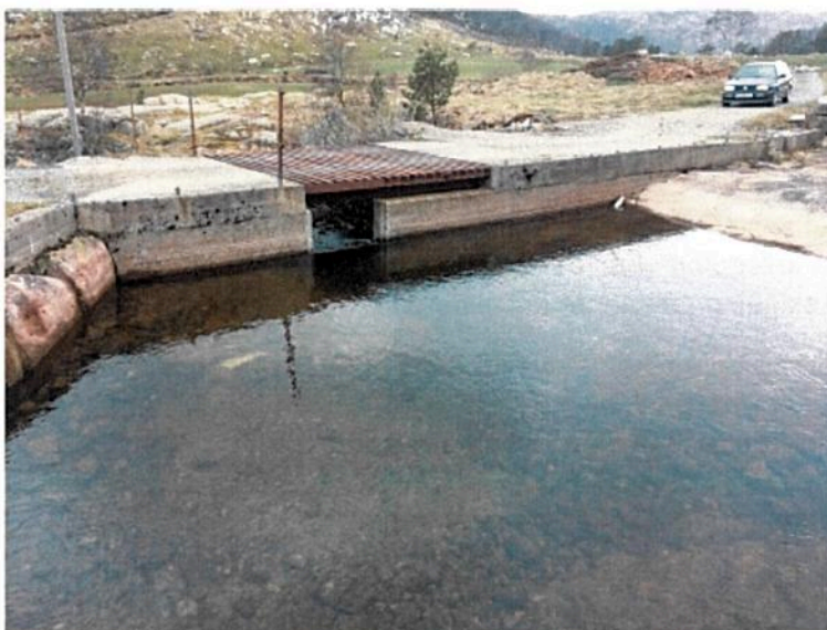
Figur 1 Dagens dam/utløp av Sætravatnet
