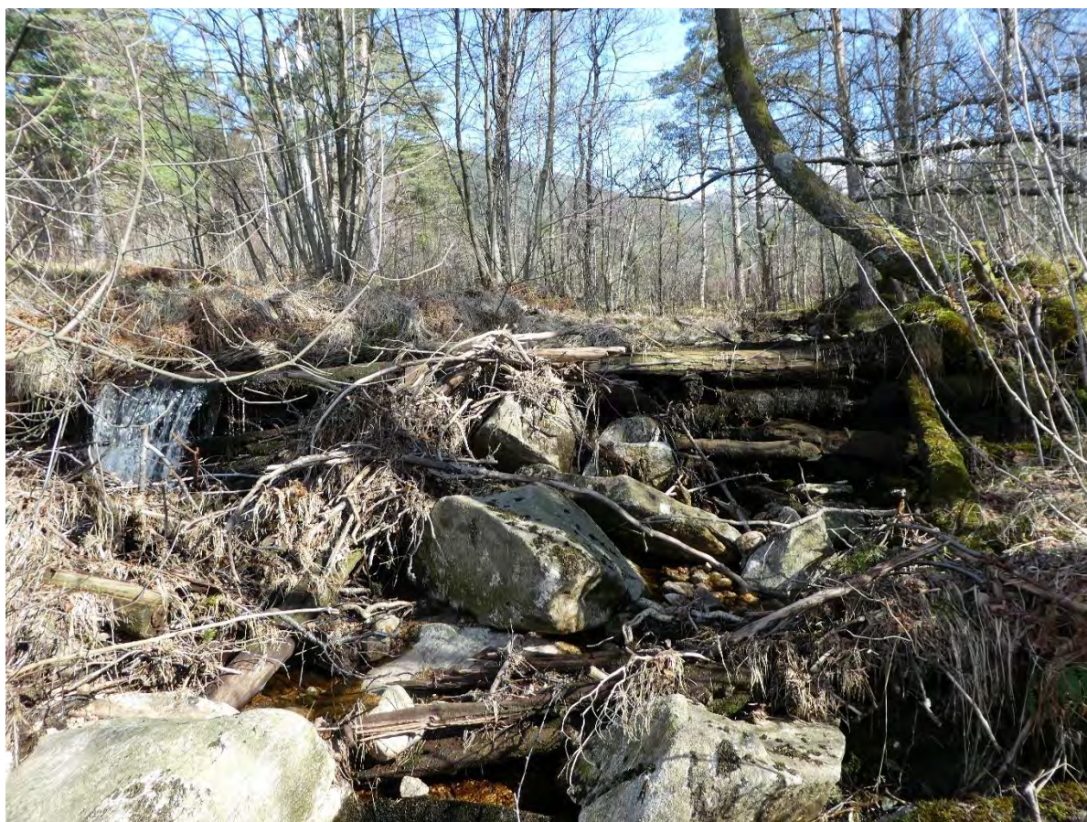
Restar etter inntaksdam til rennesystem 1
