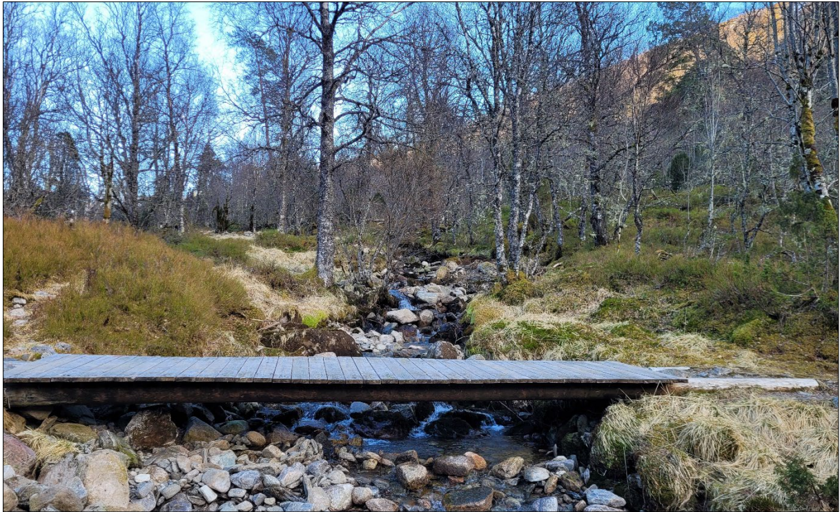
Figur 27: Brua ved infopunkt 1. SGC har fått informasjon om at brua som var her tok skade frå sørpeskredhendinga i 2017. Infopunkt 1.
