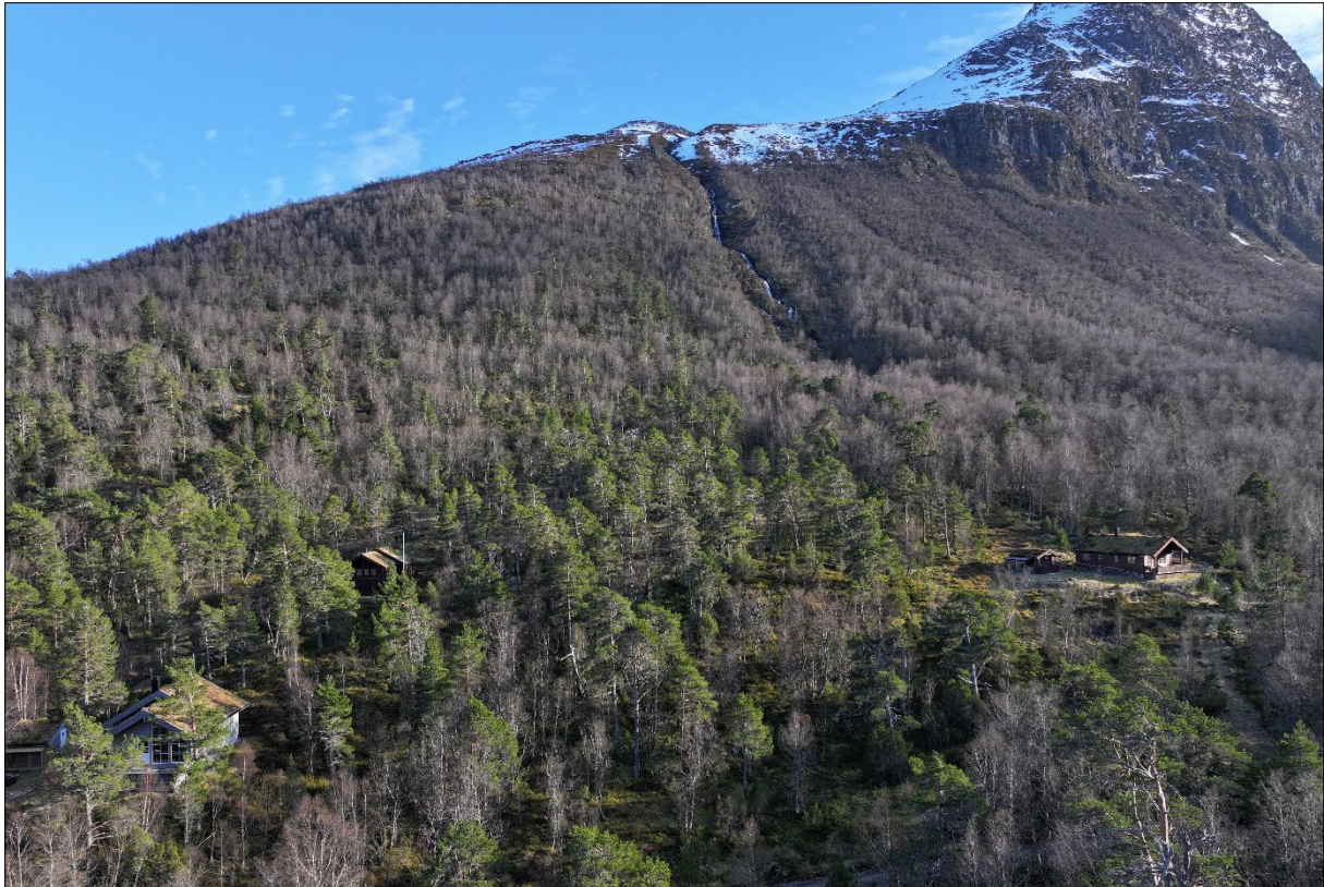
Figur 2: Dronefoto som viser oversikt over hytteområdet, i austleg del av kartleggingsområdet, og påverknadsområdet opp mot skålforma ved Botnen og Storebotnen. Bilete er tatt mot sør.
