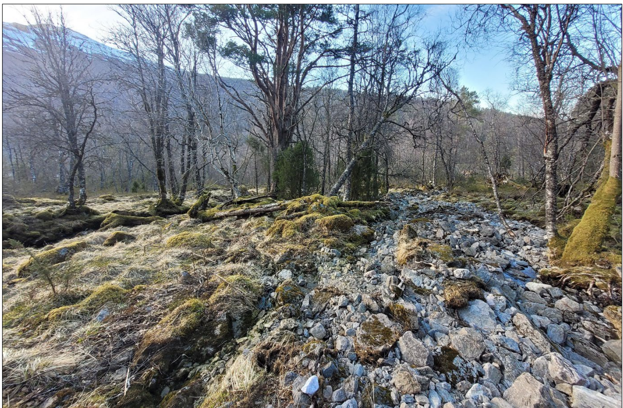
Figur 12: Spor etter avsporing frå elva, tolka å vere grunna sørpeskredhending Lausmassane består hovudsakleg av små blokker, stein og grus. Finare lausmassar er truleg utvaska og transportert vidare. Mangelen på vegetasjon indikerer ei nyare skredhending, truleg frå hendinga i 2017 (kap. 2.8, Figur 31) Infopunkt 3.
