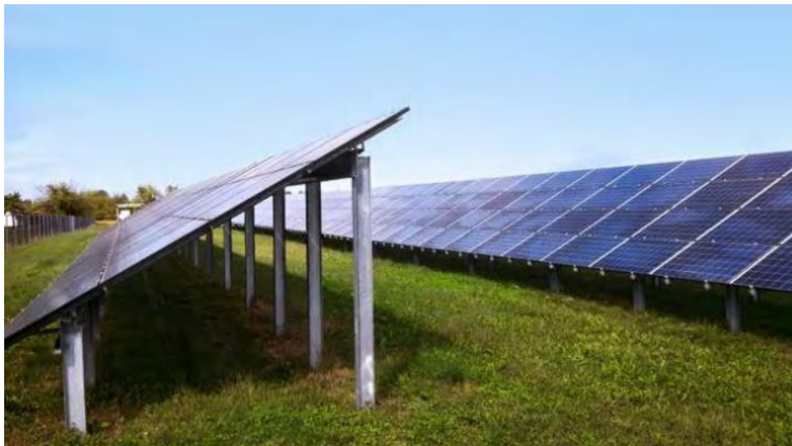
Figur 9: Eksempel på fast-vinkel installasjonsløsning (Willowbrook Solar)
