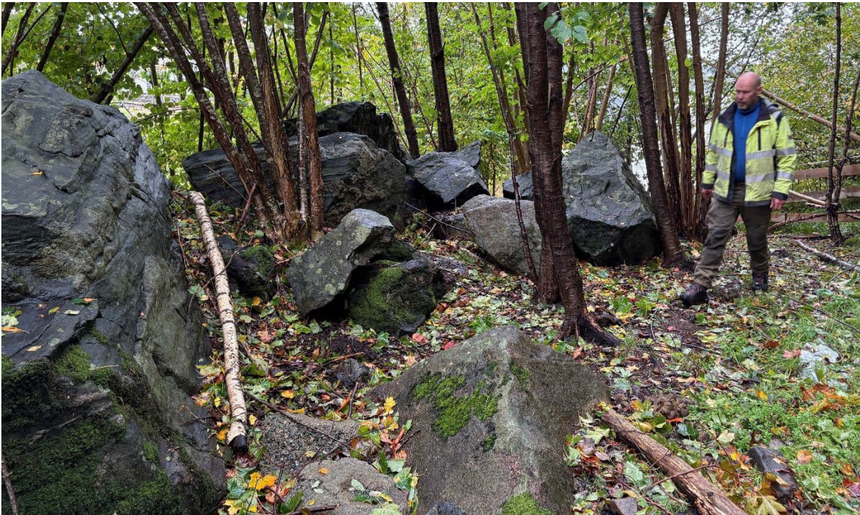
Bilde 7: Infopunkt 3 i Vedlegg 4. Steinsprangblokker i størrelsesorden 0,5-2 m 3 . Sett mot sørøst.
