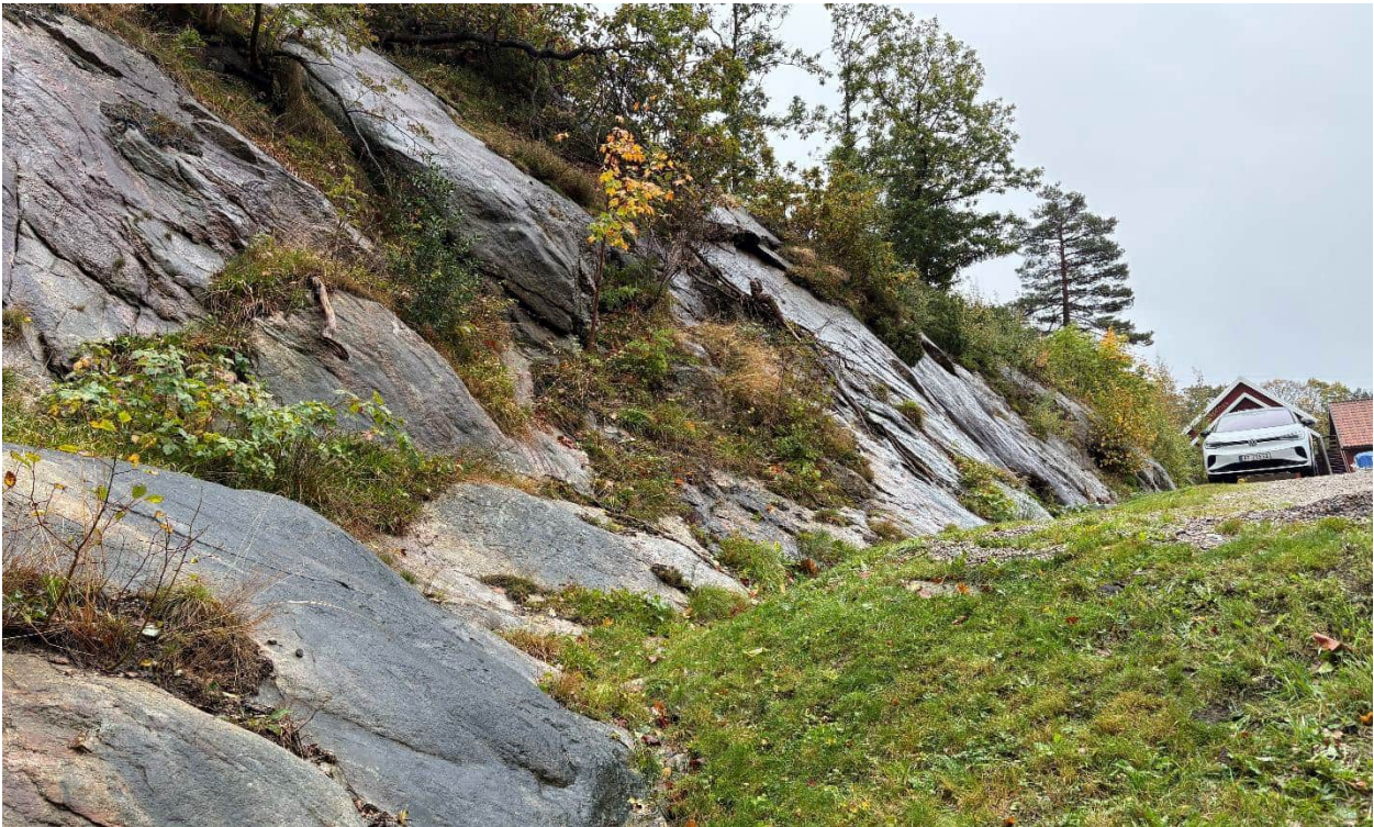
Bilde 5: Infopunkt 2 i Vedlegg 4. Bergskrent/glattskurt svaberg, med enkelte tilsynelatende avløste flak og blokker i størrelsesorden ca. 0,2-0,5 m 3 . Ca. 1-2 m bred og 0,3-0,5 m dyp grøft i bunnen. Sett mot sørøst.
