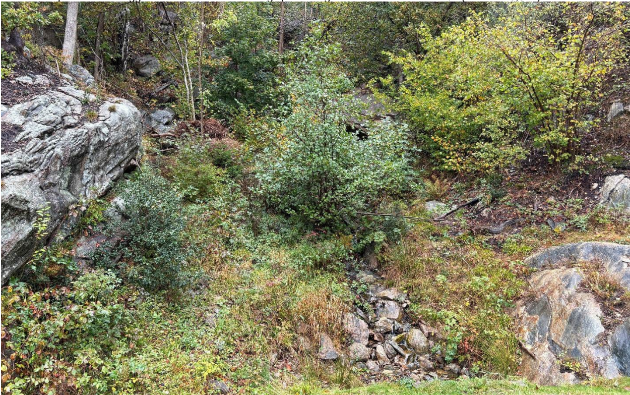
Bilde 2: Infopunkt 1 i Vedlegg 4. I nedre del av skråningen har bekken erodert seg ned gjennom et tynt lag med humusdekke og ned på steiner. Sett mot nord.
