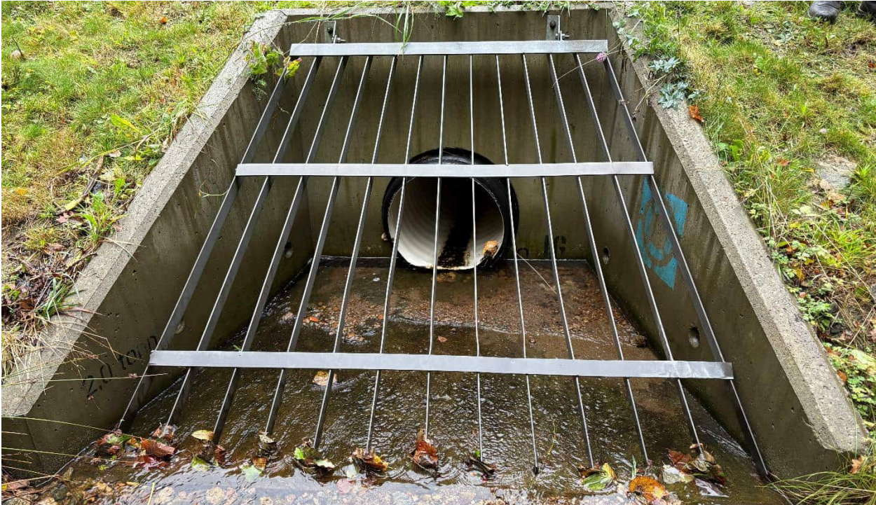
Bilde 1: Infopunkt 1 i Vedlegg 4. Bekk fra nordre skråning i påvirkningsområdet blir ledet inn i rør (diameter 0,5 m). Sett mot sør.
